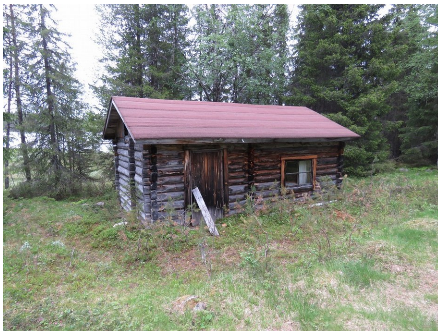
Kunnostettu saunarakennus kuvattu kaakkoon.
