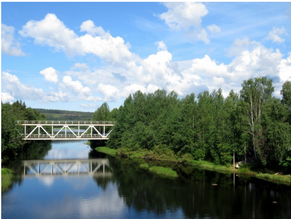
Näkymä tiesillalta länteen rautatiesillalle.
