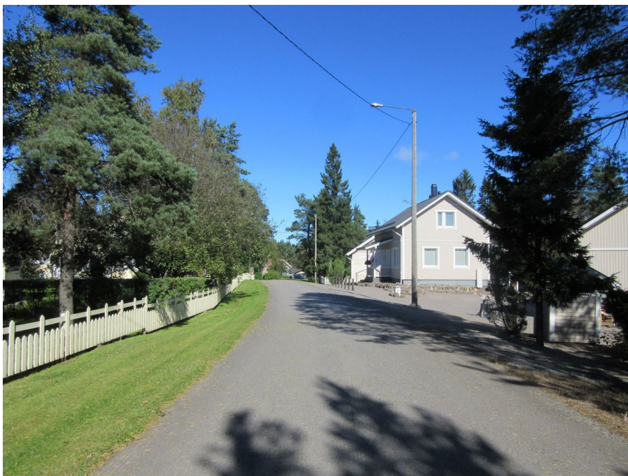
Pohjanmaan rantatien injausta Vanhalla valtatiellä, kuva pohjoiseen.
