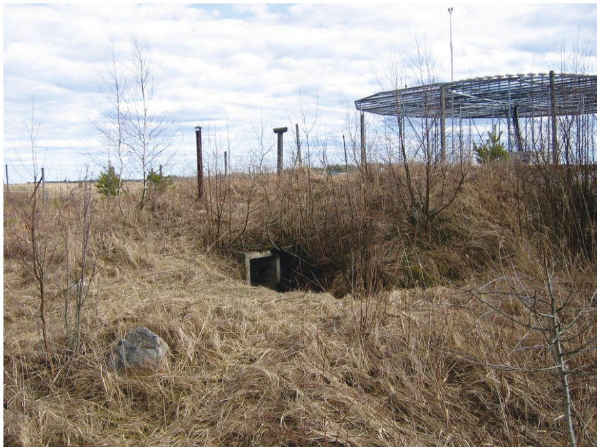
Kuva 22. Bunkkerin sisäänkäynti lentokentän pohjoispuolella.
