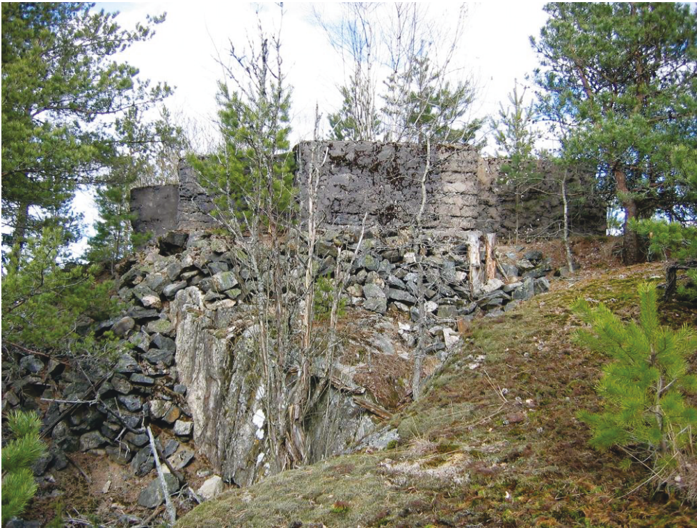
Kuva 23. Läntinen ilmatorjunta-asema Karhulankalliolla. Luoteeseen.
