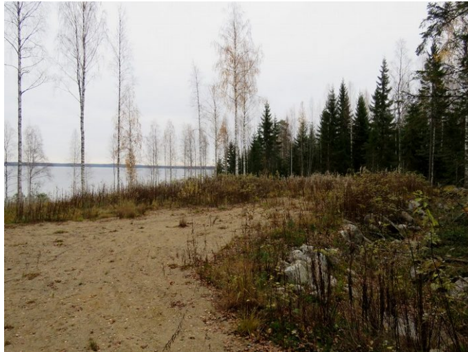
Kuva 43. Rakennuspaikka Savikannanniemen eteläpuolella. Paikalle on ajettu täyttöhiekkaa.
