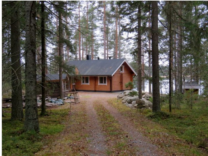
Kuva 17. Uusi mökki rakennuspaikalla Vesannonrannassa. Kivikkoinen ranta, tasanteen itäpuolella hiekkainen rinne. Länteen.
