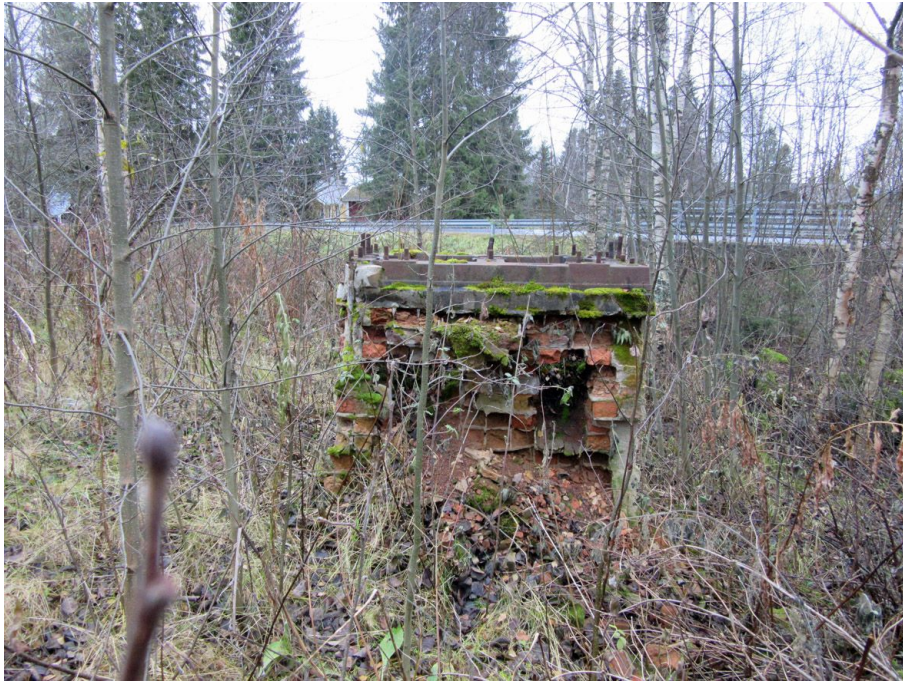
Saha- ja myllylaitokseen liittyneen rakennuksen hormin jäänteet.
