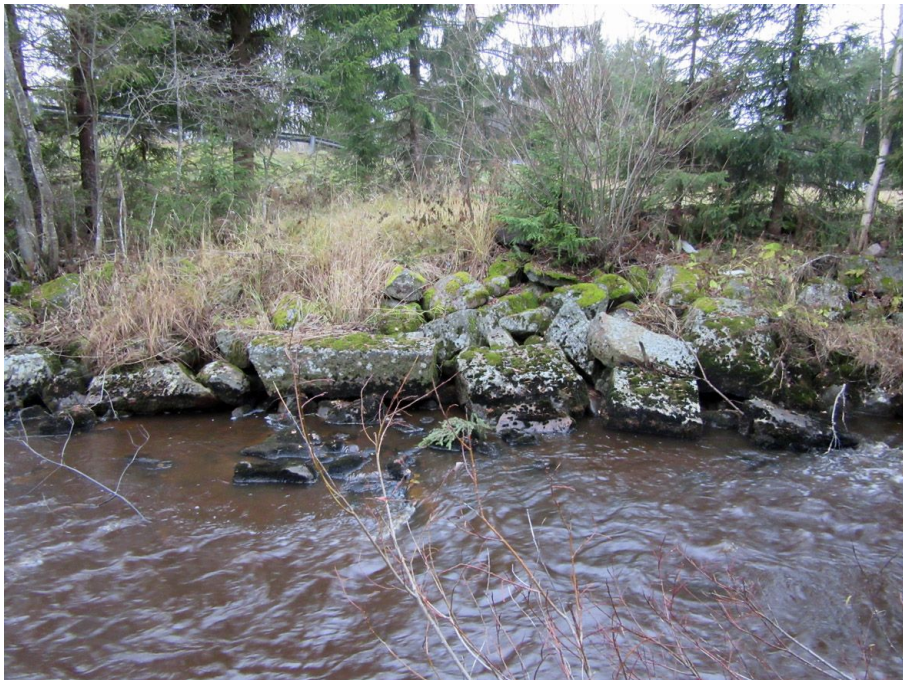
Mylly- tai sahalaitoksen ja padon ym. jäänteitä länteen.
