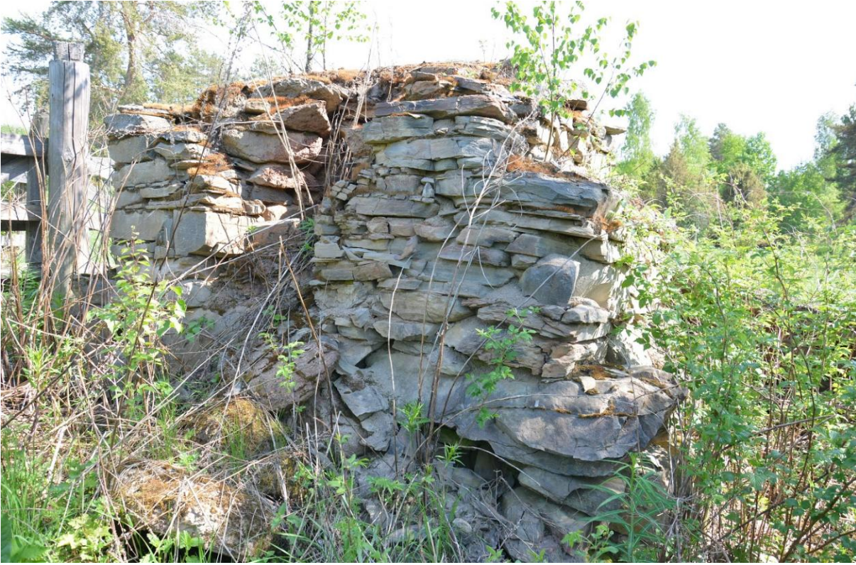
Eteläisempi riihen uuni (6825241/382678 +/- 5 m), uuni suuaukko pohjoiseen. Kuva: Ulla Moilanen. KYY 196:47.
