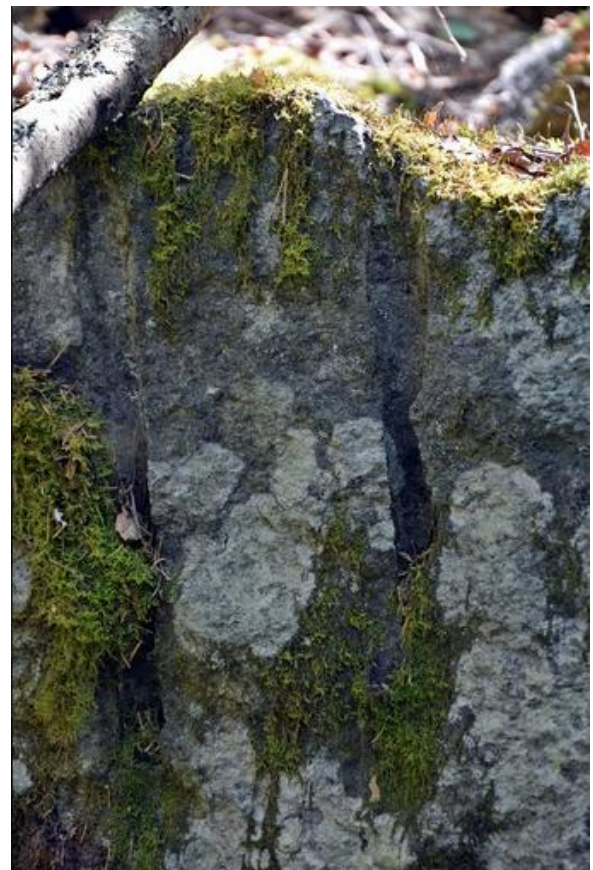
Louhoksen seinämissä näkyviä käsiporan jälkiä. Kuva: Ulla Moilanen. KY 196:64.
