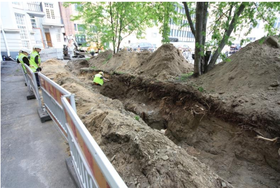
AKDG5172:19 Koeojan 1 keskivaiheilta tuli esille melko modernilta vaikuttava betonirakenne, joka erottuu ulokkeena koeojan keskellä. Rakenne tuli esille noin metrin syvyydestä nykyisestä maan pinnasta mitattuna. Sitä ei kaivettu kokonaan esille. Rakenne jatkuu koeojan 1 itäprofiiliin. Rakenteeseen liittyy suuri, noin 8 metriä pitkä ja kaksi metriä syvä kuoppa. Kuvattu lounaasta 23.5.2016. Kuva Esa Mikkola, Arkeologiset kenttäpalvelut, Museovirasto.
