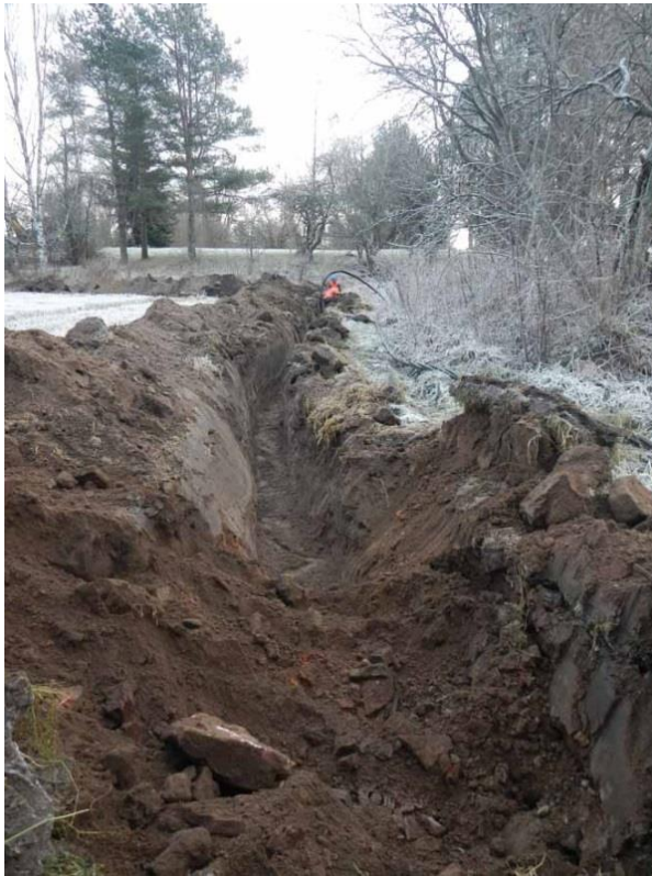
Kuva 22. Sekoittunutta mullansekaista hiesua, kiviä ja tiilenkappaleita havaintokohdassa D. Kuvattu lännestä. (Kuva: Ulvilan kirkko 2016:16)
