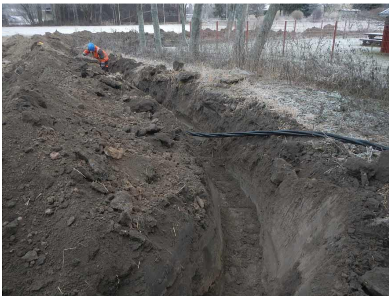
Kuva 11. Sekoittunutta hiekkaa kaapelikaivannossa havaintokohdassa A. Kuvattu länsilounaasta. (Kuva: Ulvilan kirkko 2016:6)
