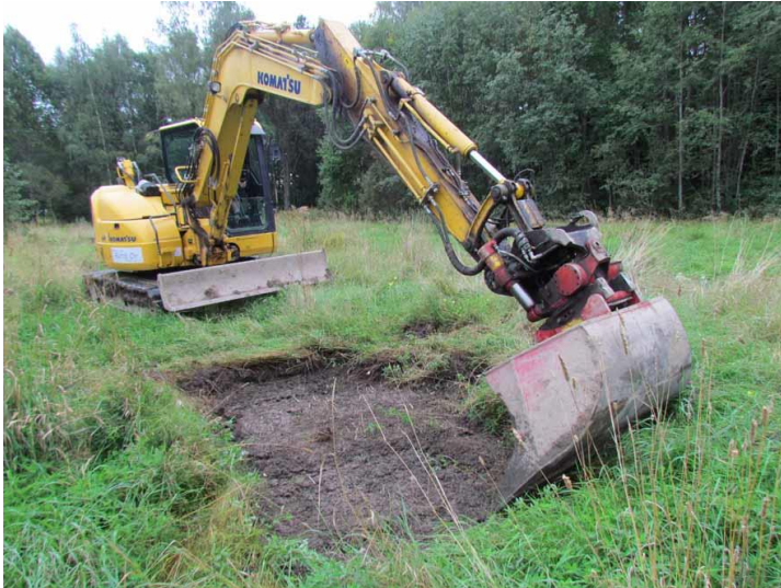
Kuva 3. Kaivinkone poistaa pellon pintakerroksia. Kuvattu luoteesta. (Kuva: Lohja Haukilahti 2016:1)
