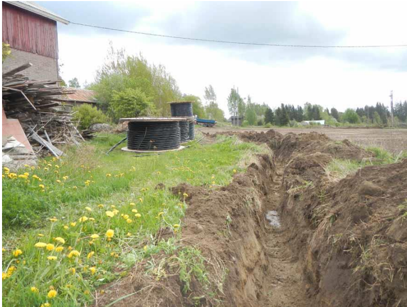
Kuva 6. Kaivulinjausta Pietilän navetan kaakkoispuolella. Kuvattu lännestä. (Kuva: Tammela Lunkaa 2016:4)
