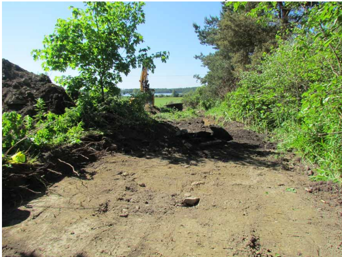
Kuva 5. Lunkaantien eteläreunaan kaivettu suuntaporan toiminta-alue. Kuvattu pohjoiskoillisesta. (Kuva: Tammela Lunkaa 2016:3)
