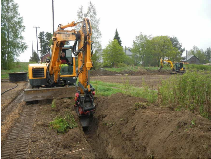
Kuva 4. Maakaapelin kaivamista linjan itäosassa. Taaempi kaivinkone täyttää kaivantoa edessä olevan kaivaessa. Kuvattu etelälounaasta. (Kuva: Tammela Lunkaa 2016:2)
