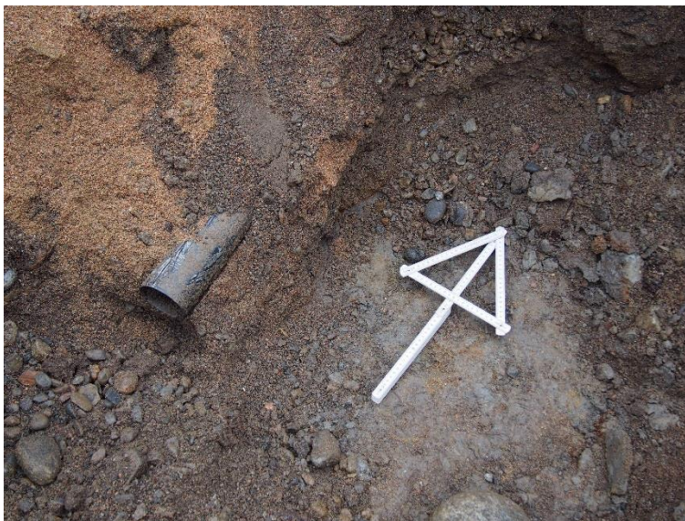
Kuva 4. Tyhjä muoviputki koekuopassa 2 noin metrin syvyydessä.
