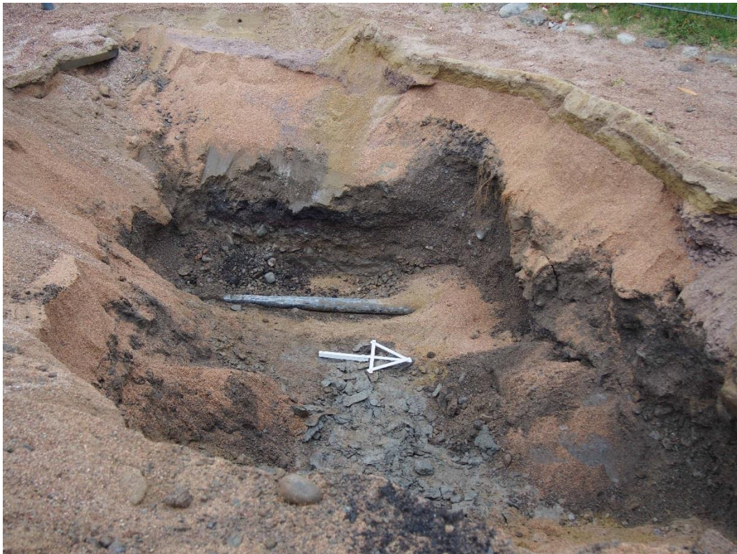
Kuva 3. Koekuoppa 1. Kuopan pohjalta noin 1 metrin syvyydeltä paljastui käytöstä jäänyt pohjoinen-etelä –suuntainen muovinen suoja-putki.
