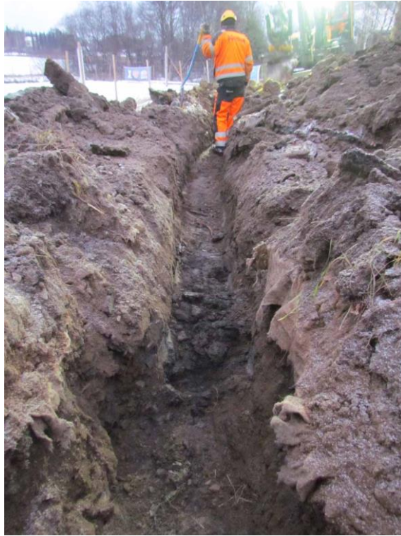
Kuva 10. Orgaanista ainesta sisältänyt savikerros maakaapelikaivannossa. Kuvattu lounaasta. (Kuva: Lempäälä Herrala ja Hääkivi I 2016: 7)
