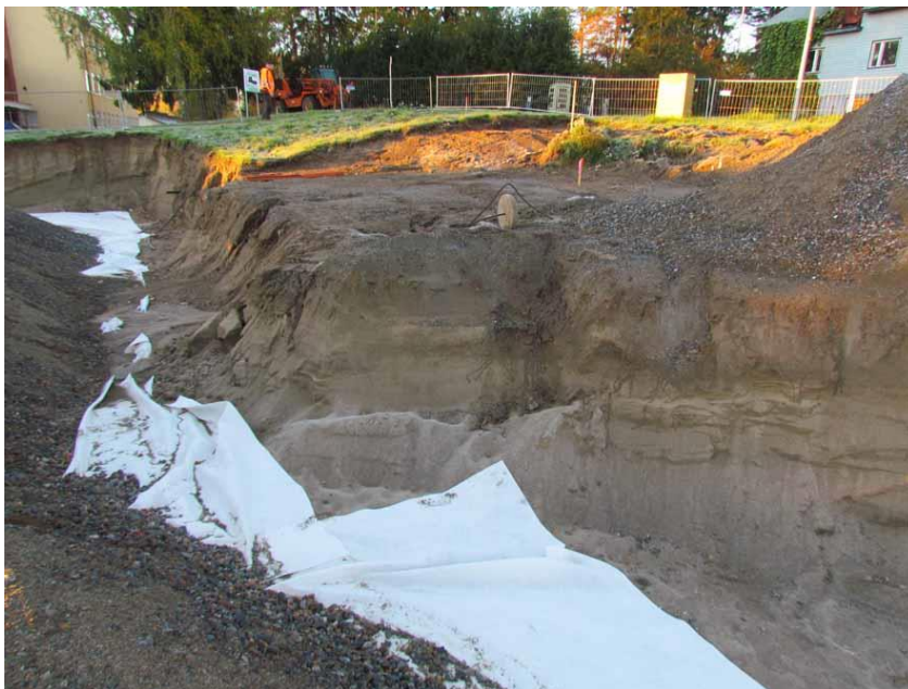
Kuva 5. Valvottavan alueen ja sen itäpuolen jo kaivetun alueen välille jäi maaleikkaus, jota havainnointiin silmämääräisesti ennen kaivutyön ja valvonnan aloittamista. Kuvattu pohjoiskoillisesta. (Kuva: Pälkäne Ristiänmäki 2016: 2)
