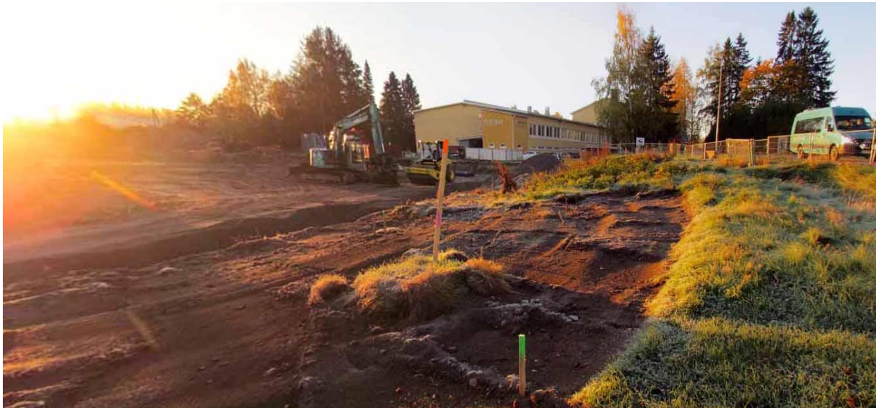
Kuva 4. Alue, jonka kaivuuta valvottiin rajautuu kuvassa takana näkyvän työmaa-aidan ja kuvan edustalla olevaan vihreäpäisen puupaalun väliin jäävälle alueelle. Kuvattu pohjoisesta. (Kuva: Pälkäne Ristiänmäki 2016: 1)
