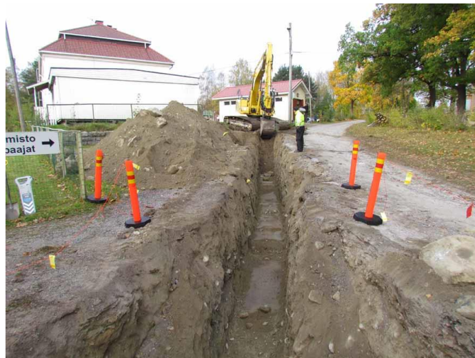
Kuva 10. Aluelämpö- ja vesiputkikaivantoa vankilanmäelle nousevan tien lounaisreunassa. Kuvattu itäkaakosta. (Kuva: HML Ojoinen 2016: 6)
