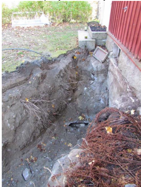
Kuva 6. Rakennuksen 003 pohjoisseinustan kaivannon koillisprofiili. (Kuva: HML Ojoinen 2016: 2)
