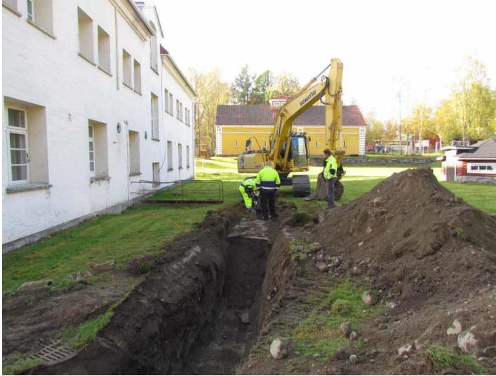
Kuva 5. Aluelämpö- ja vesiputkireittiä kaivetaan työsiirtolan (rakennus 007) pohjoisseinustalle. Kuvattu idästä. (Kuva: HML Ojoinen 2016: 1)
