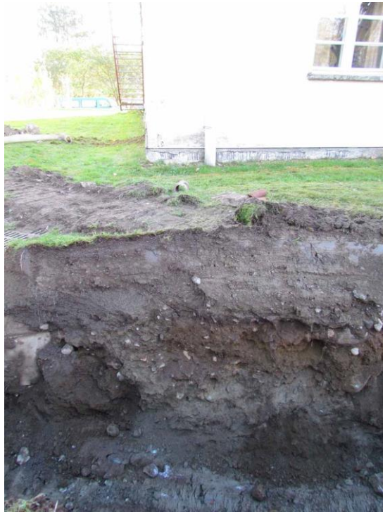
Kuva 11. Kaivannon eteläprofiili työsiirtolarakennuksen koilliskulman kohdalla. (Kuva: HML Ojoinen 2016: 7)
