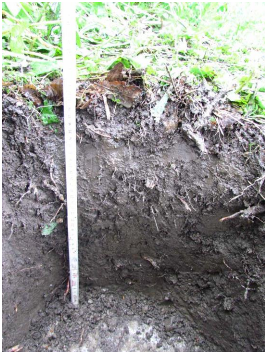
Kuva 40. koekuoppa 6, eteläprofiili. (Kuva: Lempäälä tarkkuusinventointi 2016: 35)
