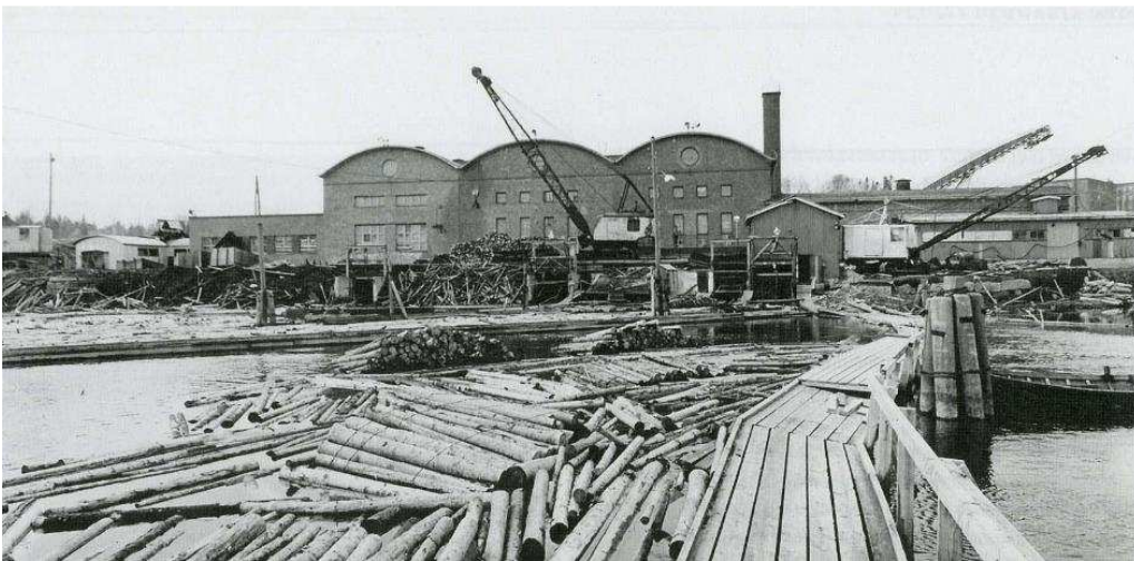
Kuorimo itäpuolelta kuvattuna vuosien 1959 ja 1972 välillä. Kuva: Toivola, Puusta pehmopaperiin –teoksesta.
