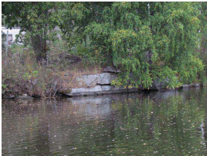
Virran penkereen tukimuuria. Kuvattu kaakosta. (Kuva: Nokia Sahanranta 2015: 19)
