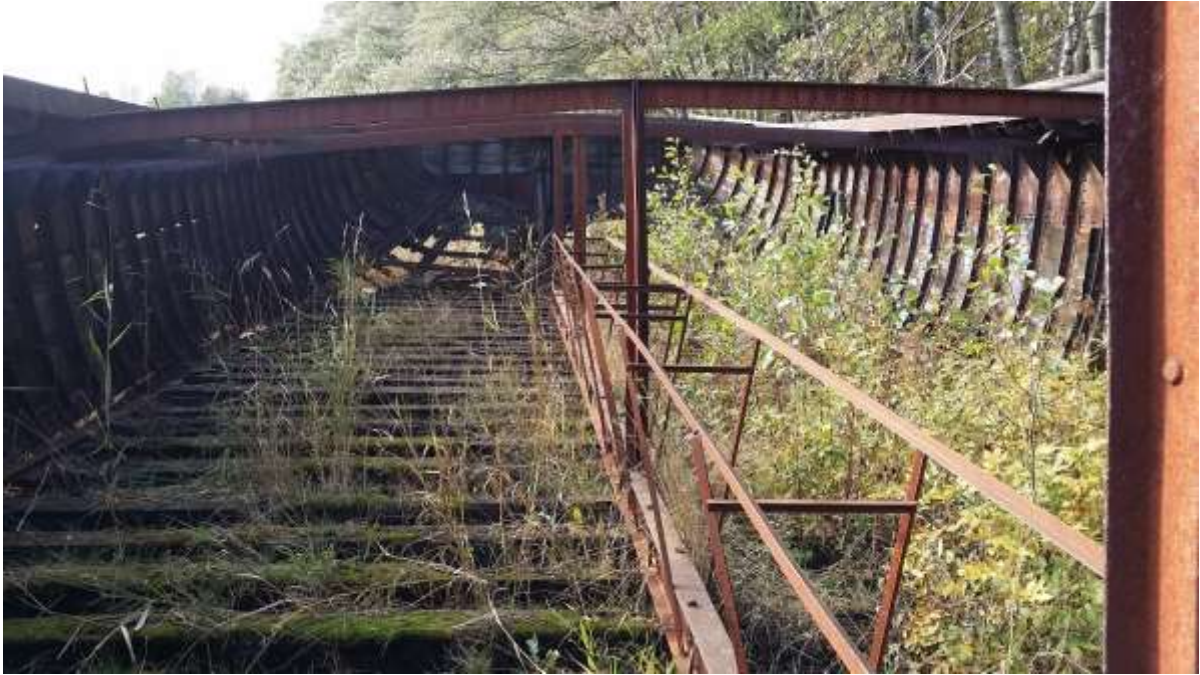
Kuva 9. Lillfjärdenin proomunhylyn rungon tukirakenteita. ©Rami Kokko / ARK-sukellus.
