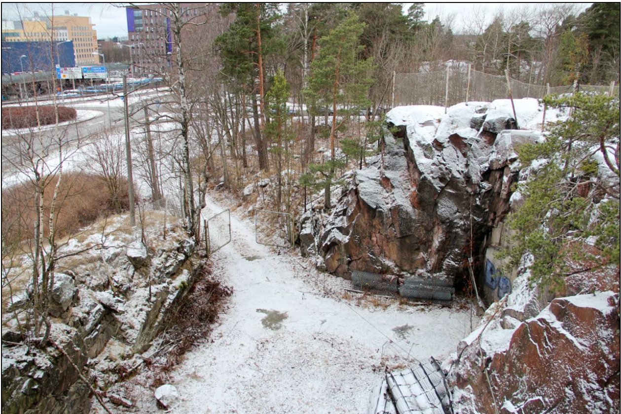
Kuva 8. Sisäänkäyntien edessä oleva kallioleikkaus ja luolan G7 ulkoseinä koillisen suuntaan kuvattuna. Kalliosta myöhemmin louhittu alue on vasemmalla, kumisten räjähdysuojamattojen kohdalla. AKDG49189:6.
