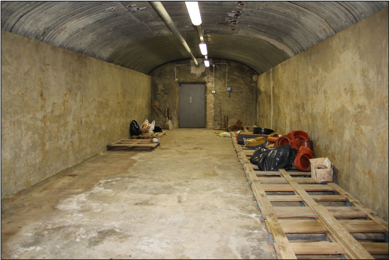
Kuva 25. Luolan G7 varastotila etelän suuntaan kuvattuna. Kuva: AKDG49189:31.
