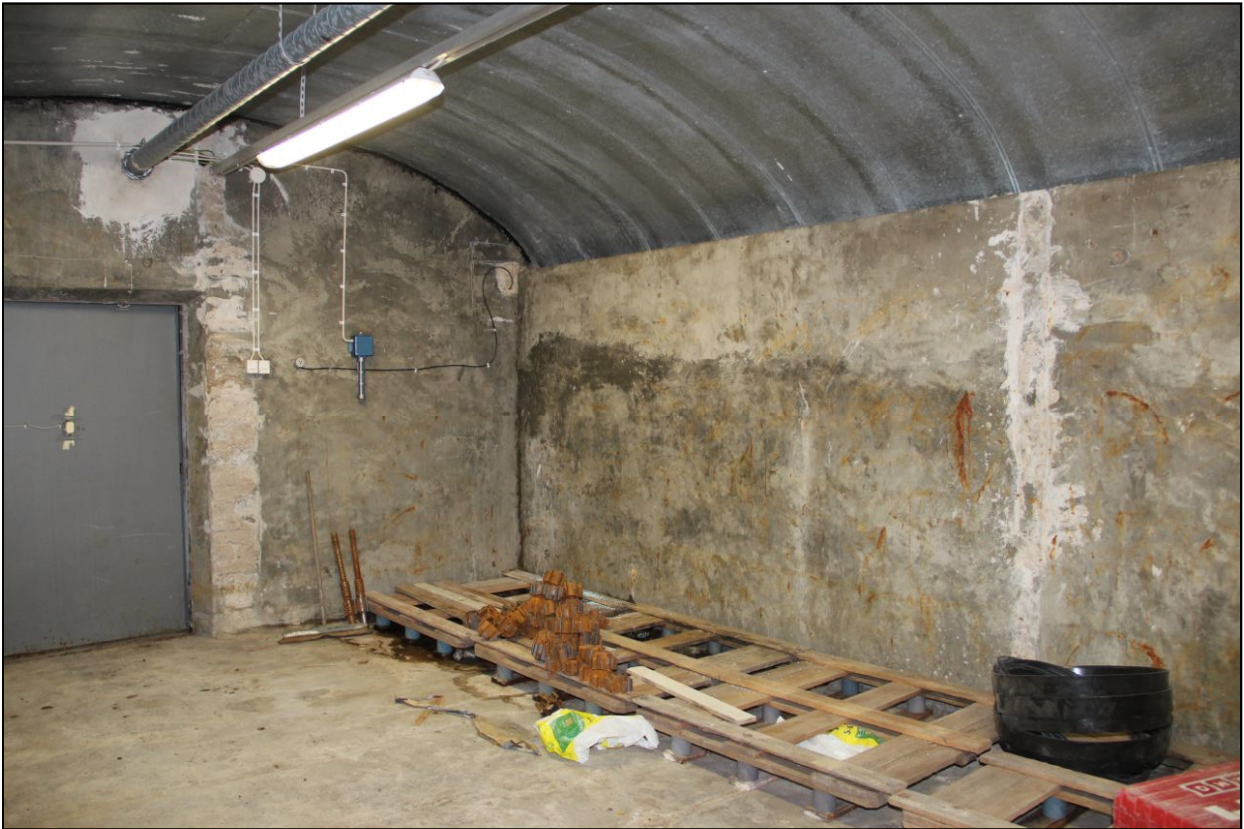
Kuva 27. Luolan G7 varastotila. Betoniseinien pinnoilla näkyy jälkiä tiilestä muuratuista väliseinistä oven oikealla puolella ja kuvan oikeassa reunassa. Kuva: AKDG49189:35.
