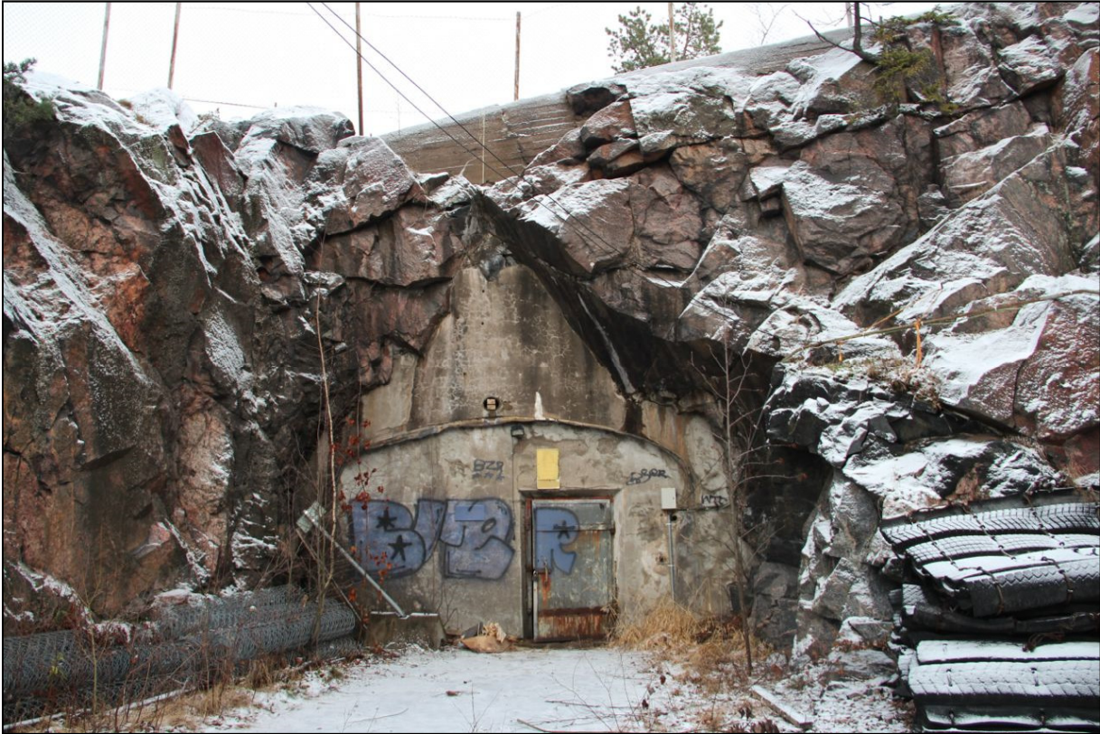
Kuva 9. Luolan G6 ulkoseinä. Kalliokaton yläreunaa on vahvistettu betonilla. Kuva: AKDG49189:4.
