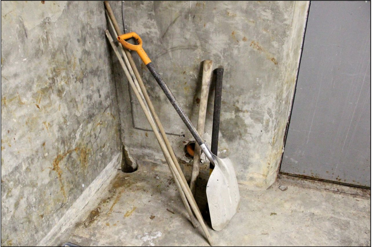
Kuva 29. Luolan G7 varastotilan uloskäynnin puoleisen pään kummassakin nurkassa on lattiassa aukot vedenpoistoa varten. Kuva kaakon suuntaan. Kuva: AKDG49189:40.
