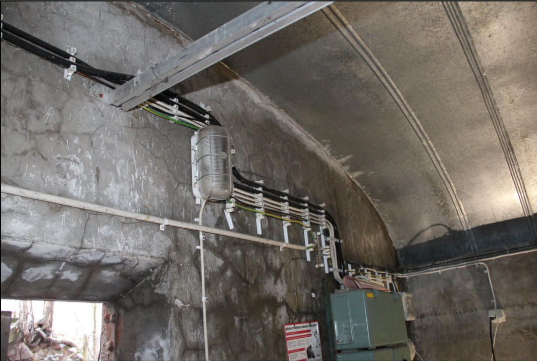
Kuva 12. Luolan G6 eteinen lounaan suuntaan kuvattuna. Katon alkuperäiset aaltopellit on poistettu ja korvattu uusilla. Luolan sähkölaitteet on myös uusittu myöhemmin. AKDG49189:12.
