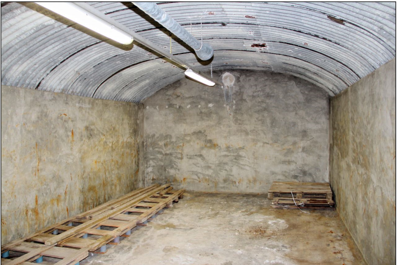
Kuva 26. Luolan G7 varastotilan takaseinän vasemmassa puolella näkyvät vanhojen sähköjohtoasennuksen kiinnitysreiät umpeen kitattuina vaaleina pisteinä. Kuvattu pohjoisen suuntaan. Kuva: AKDG49189:34.
