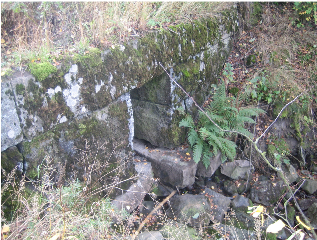
Kuva 8. Knaapinahteen siltarumpu. Pohjoisesta. (SKDG201505:10).
