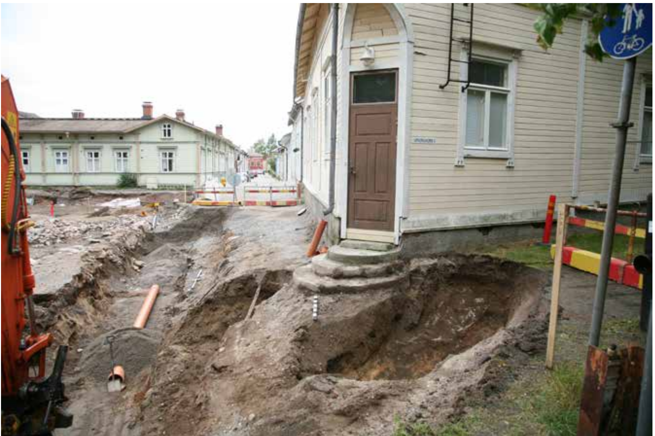
MuTu116012Dg_23. Alue 8. Vanhankirkonkadun ja Itäkadun risteuksen koilliskulman talon kulmaoven sivuille tulevien hulevesikaivojen kaivannot. 16.8.2016. Etelästä. J. Haarala.
