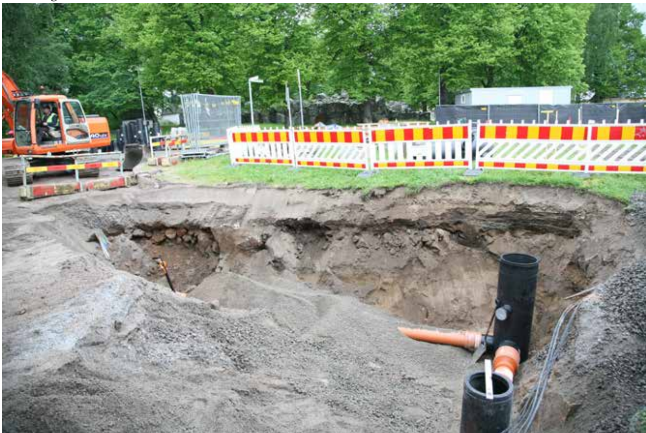
MuTu116012Dg_16. Alue 8. Itäkadun länsiprofiilissa katualueen ulkopuolella säilyneitä kulttuurikerroksia ja kivikkoa. 16.6.2016. Idästä. J. Haarala.
