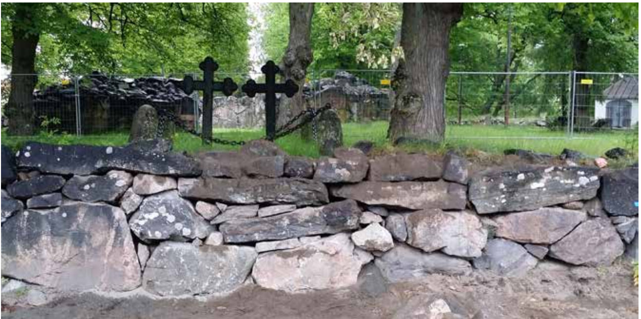
MuTu316012Dg_4. Läntinen kirkkoaita korjattuna. 16.6.2016. Länestä. J. Lehtola
