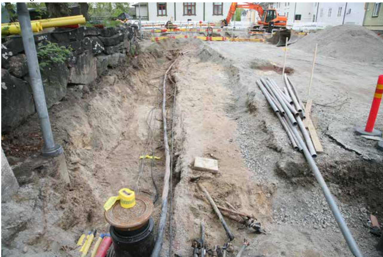
MuTu116012Dg_3. Alue 5. Putkikaivannon eteläosa Turunkadulla. Kirkon länsipuolen aitaa. Kaivanto yhdistetty alueeseen 6. 19.5.2016. Pohjoisesta. J. Haarala.
