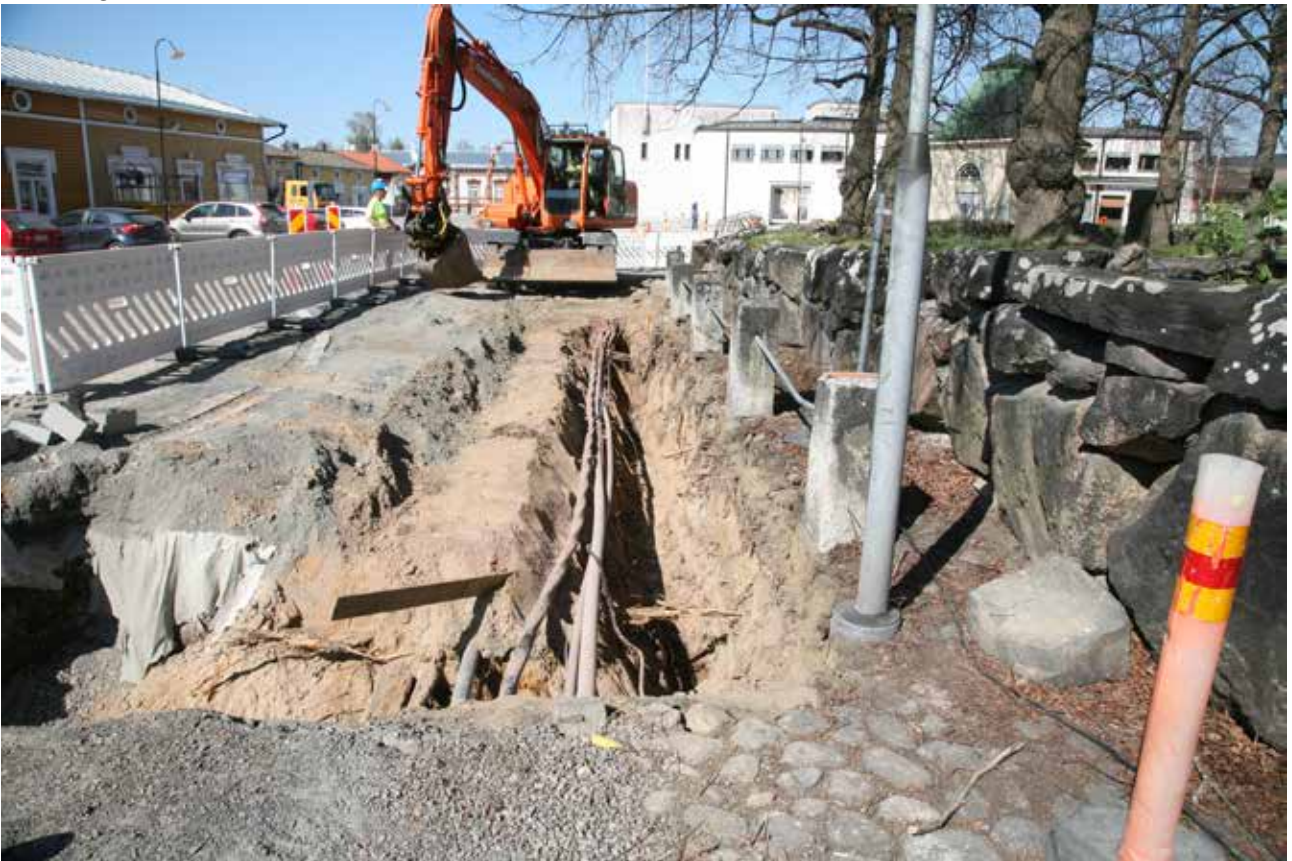
MuTu116012Dg_1. Alue 5. Putkikaivannon sijainti Turunkadulla hevospuumien edessä. 10.5.2016. Etelästä. J. Haarala.
