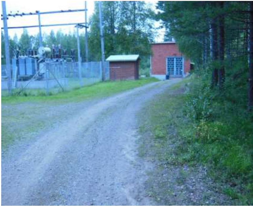
Kuva 3. Alkukuva. Kaaraneskosken voimala. Tien viereen kaivetaan kaapelit. (luoteeseen)
