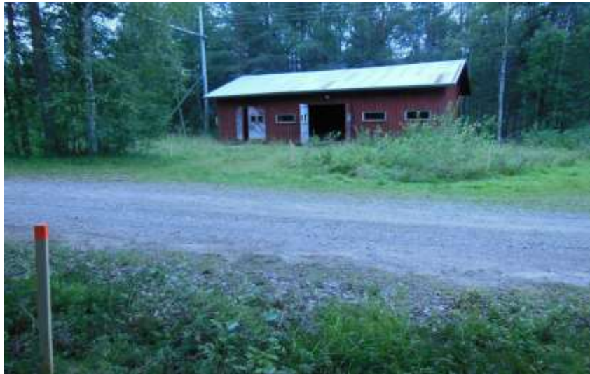
Kuva 2. Alkukuva. Sähköaseman laajennusosa on merkitty pienillä paaluilla varastorakennuksen edustalle. (lounaaseen).
