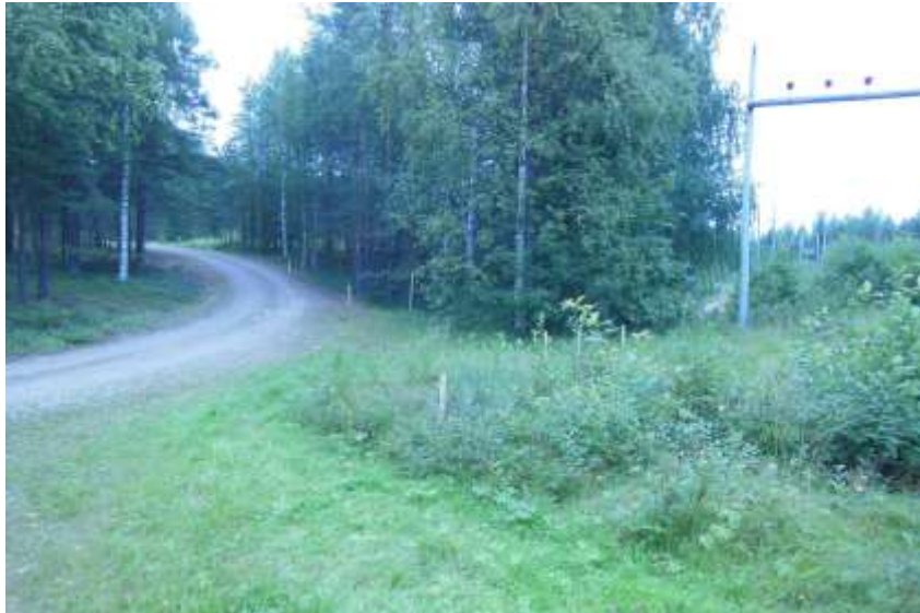
Kuva 1. Alkukuva. Sähköaseman laajennus. Tornionlaakson Voima Oy oli merkinnyt paaluilla kaapelinlinjat sekä sähköaseman rakennuspaikan. (kaakkoon)
