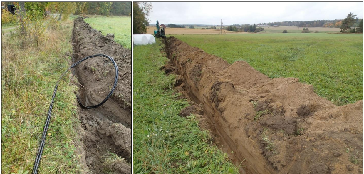
Vasen kuva: pohjoisin (itä-länsi-suuntainen) osuus. Lännessä. Oikea kuva: kaivannon maaperältään hiekkaisista osaa linjan läntisessä osassa. Pohjoiskoillisesta.
