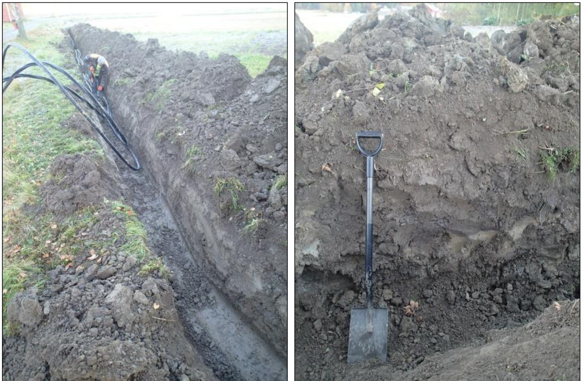
Vasen kuva: valvotun linjan pellolla sijainnut länsipää. Idästä. Oikea kuva: tumman maan kerros puutarhan länsireunassa 5 m päässä pellon reunasta. Maan pinta on lapion kahvan alareunan kohdalla, tumman maan pohja lapion puolivälissä. Etelästä.
