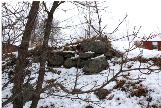
AKDG5145:15 Vallin lounais- eli ulkosivun puolustusmuuria oli säilynyt muutamassa kohdassa pari kiverroksta. Eteläisempi osa. Lännestä. Kuva Katja Vuoristo.
