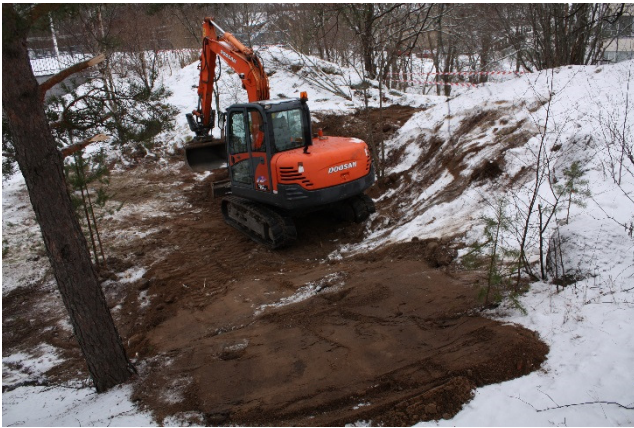
AKDG5145:23 Koeojaa täytetään. Pohjoisesta.
