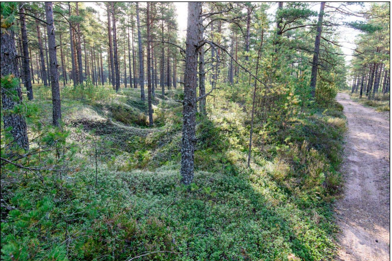
Kuva 6. Panssarivaunun kaivantoeste kulkee tien suuntaisesti metsässä. Este on jaettu poikittaisvalleilla keskimäärin kolmen metrin osioihin. Koverhar 15. Kuva: AKDG5031:1. Vesa Laulumaa.
