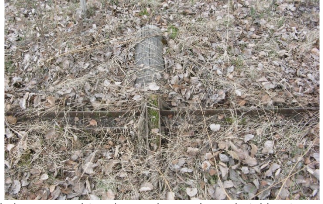
SKDG201702:19 ja 24. Oik. pylvään alaosa tukikiveyksineen, vas. irtonainen pylvään alaosa ja tukirauta.
