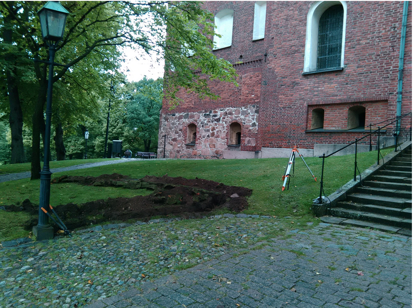
Kuva 3. Uudelle valaisinpylväälle puun viereen toiselta valaisimelta johtava kaapelikaivanto. Kaakosta, M. Helmaa 22.8.2016. MuTu116018Dg_3.
