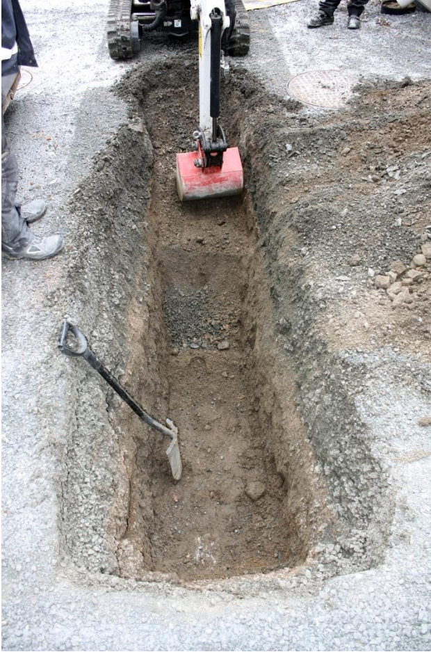
Kuva 6. Viemäriputken ojaa kaivetaan, kuvattu pohjoisesta. AKDG 5201:5
