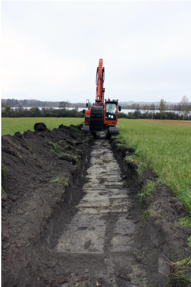
Kuva 6. Koeoja 1, kuvattu koillisesta. AKDG 5126:5
