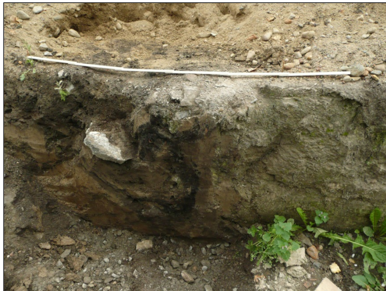
Rakenne 6 perustuskaivannon itäpuolen seinämässä.
