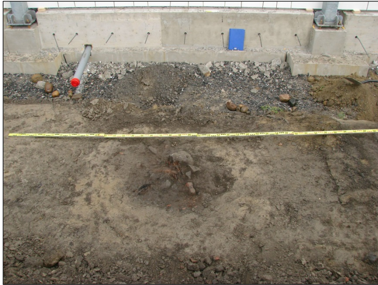
Rakenne 5 puhdistettuna esille.
