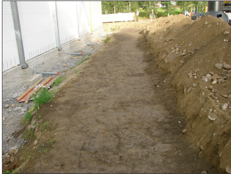
Kaivausalue 1 pohjustussoran poiston ja lähtötason puhdistuksen jälkeen. Idästä.
