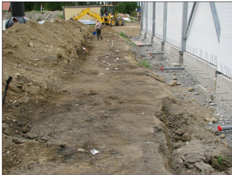
Kaivausalue 1. pohjustussoran poiston ja lähtötason puhdistuksen jälkeen. Lännestä.
