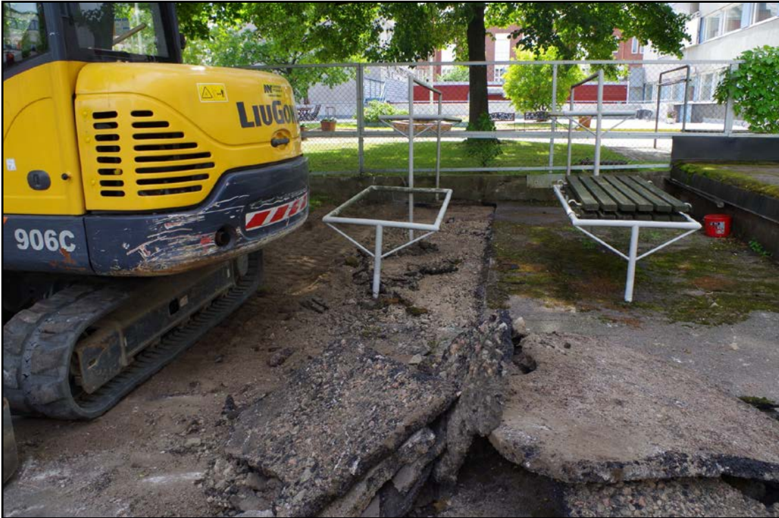
Kuva 8: Alueelle D tehdyn uuden pysäköintiruudun tieltä poistettiin toinen piha-alueen SW-päässä sijainneista mattotelineistä. Kuvassa alue kun piha-asvaltti on poistettu. NE. Kuva: KyM/M. Kykyri.
