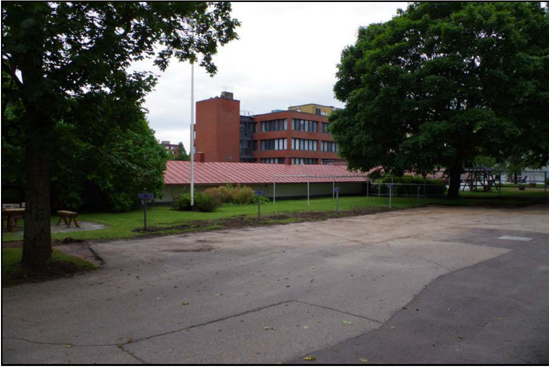
Kuva 18: Alueet A-D täytettyinä maankaivu- ja kaapelointitöiden jälkeen. N. Kuva: KyM/M. Kykyri.
