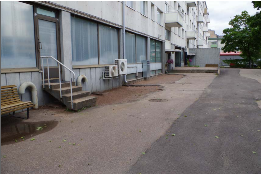
Kuva 19: Alue E täytettyinä ja tasoitettuna piharakennustöiden jälkeen. SW. Kuva: KyM/M. Kykyri.
