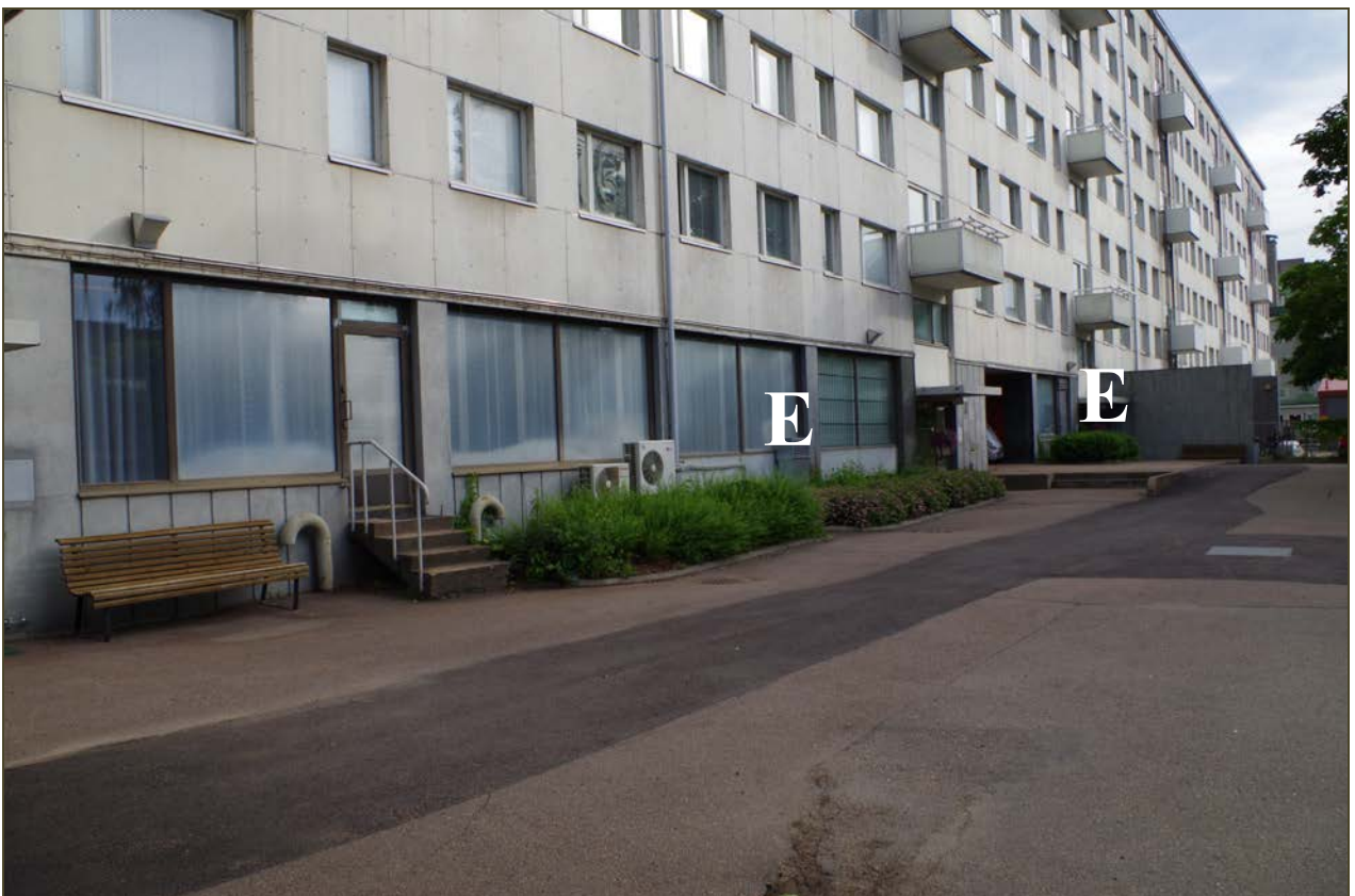
Kuva 3: Piha-alueen NW-sivustaa ennen koristepensaiden ja istutusalueita rajaavien betonisten reunakivien poistoa. Poistetut istutusalueet pensaineen on merkitty kuvaan E-kirjaimella. S. Kuva: KyM/M. Kykyri.
