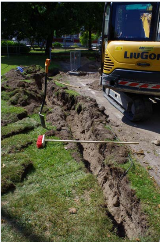
Kuva 6: Kaapelioja B:n NE-pää pohjaan kaivettuna. NE. Kuva: KyM/M. Kykyri.
