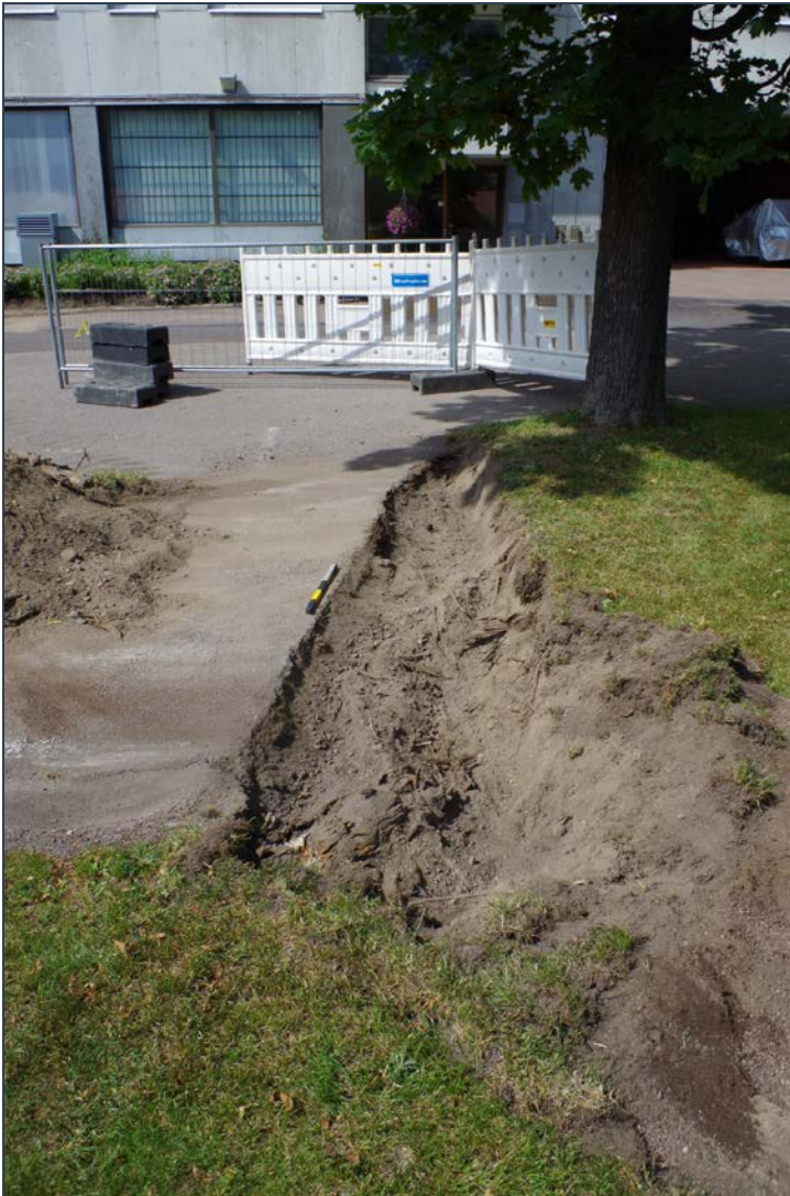
Kuva 7: Kaapelikaivanto B:n koillispuolella sijainnut matala ja kapea kaivanto C lopulliseen syvyyteen kaivettuna. SE. Kuva: KyM/M. Kykyri.
