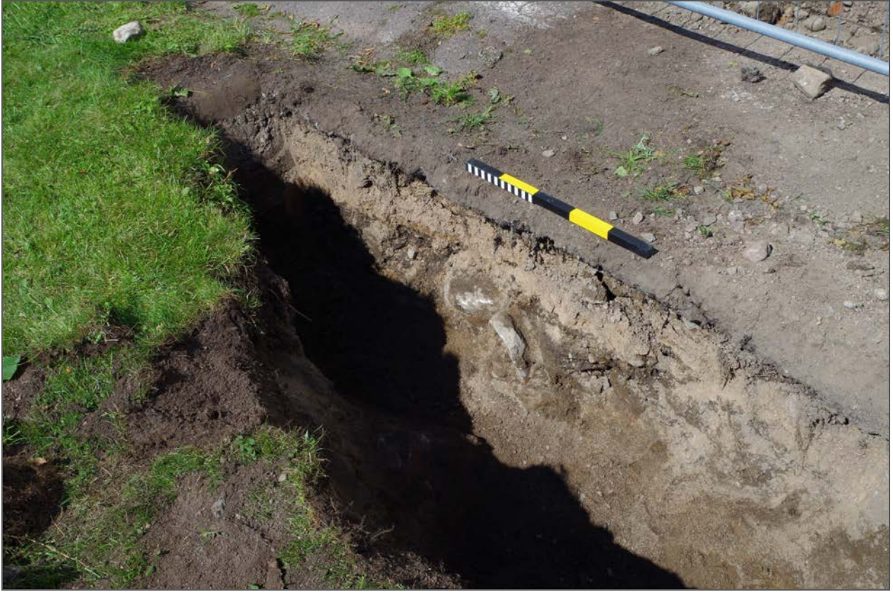
Kuva 12: Kapean kaapelikaivannon B lounaispään NW-seinämän kerroksia ja rakenne R1:een todennäköisesti kuuluneita kiviä. E. Kuva: KyM/M. Kykyri.
