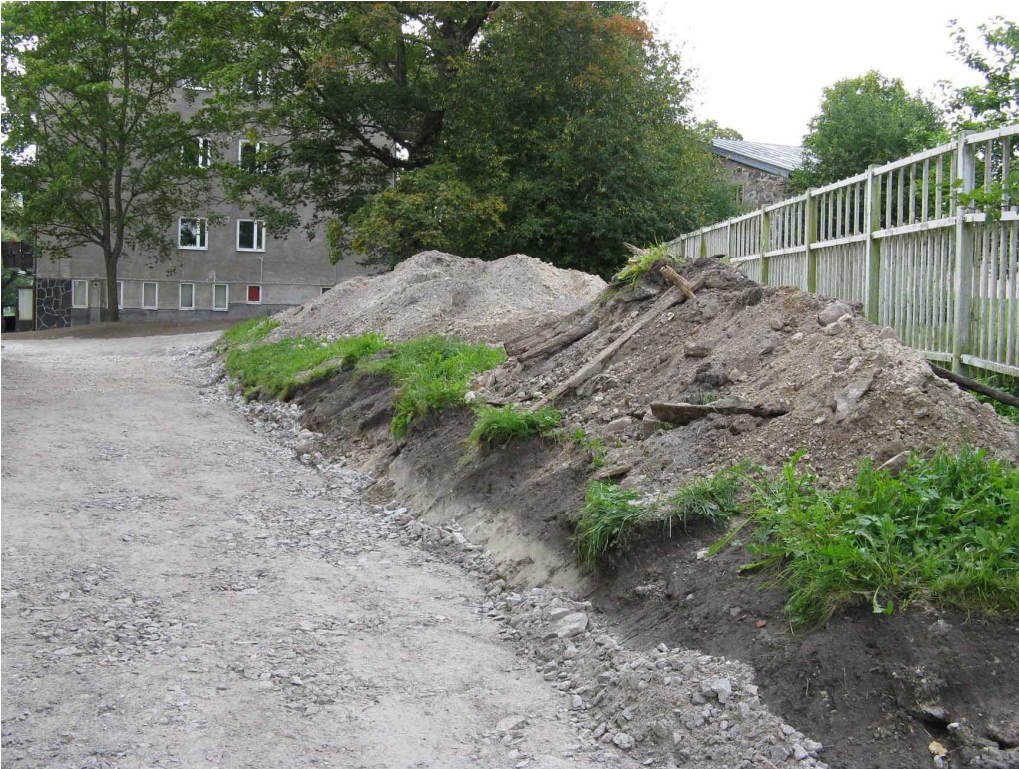
Rakennuksen 156d ja tontin läntisen raja-aidan välillä oleva penkka/alue, josta viistettiin maata. Kuvassa vielä ilmeisesti rakennuksen vierustan kaivuun jäljiltä olevaa maakasaa, jossa näkyy irtolankkuja sekä taustalla uutta soraa täyttöä varten. Itse rakennus jää kuvan rajauksen vasemmalle puolelle. Taustalla rakennus 156c. Kuva Heini Hämäläinen/HKM 26.8.2010. Kuvaussuunta N-S.
