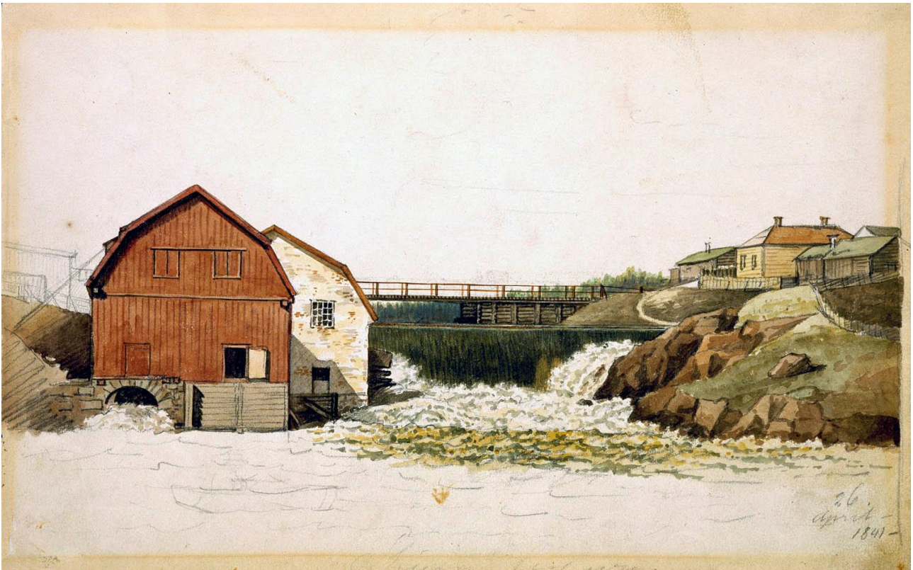
Helsingin Vanhankaupunginkoski. Magnus von Wrightin akvarelli putouksesta ja myllyrakennuksista v. 1841. Punaisen puurakenteisen myllyn kivijalka löytyi vuoden 1988 kaivauksissa. Kuva: HKM.
