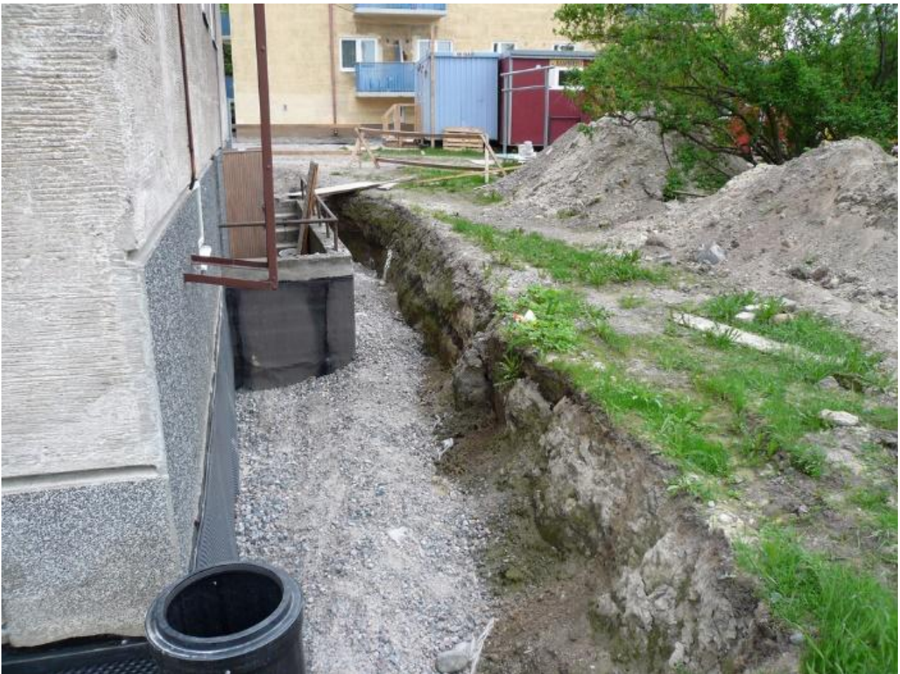
Rakennuksen 156b pohjoisseinusta avattuna vuonna 2007, jolloin rakennuksen seinustalle tehtiin salaojitusta. Tuolloin rakennuksen seinusta oli avattuna kapeammalta vyöhykkeeltä kuin vuonna 2010. Kuvaussuunta W. 25.5.2007. Markku Heikkinen/HKM
