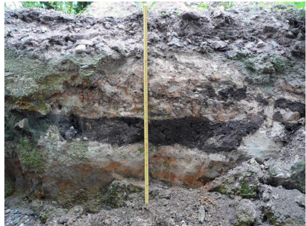
Hämeentie 156 2007. Koillisen rakennuksen Hämeentie 156b:n pohjoisseinän kaivanto. Yläosan vaalean täyttömaan takana oli kaapelilinja. Havaintopiste 5. Kuvaussuunta N. 25.5.2007.
