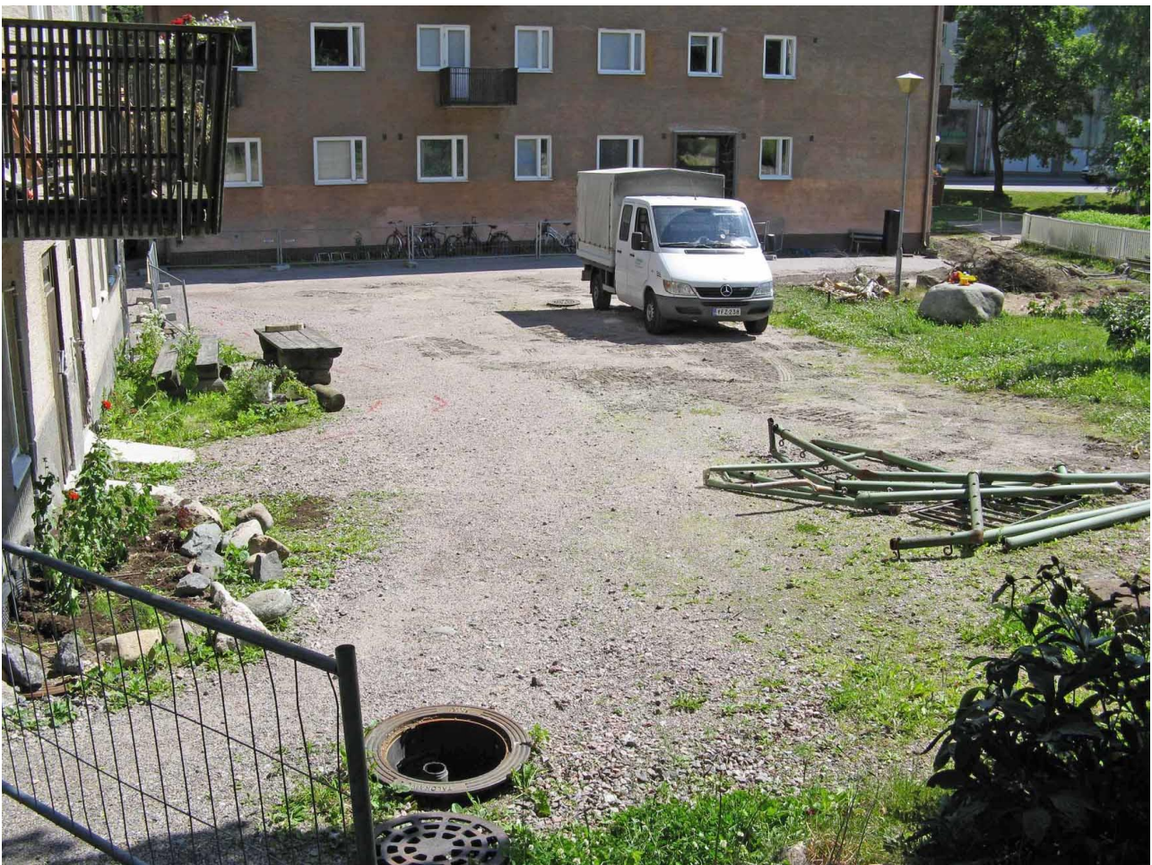
Pihan eteläosaa ennen valvonnan alkamista lännestä kuvattuna. Vasemmassa reunassa rakennus 156c ja taustalla 156a, jonka eteläpuolelta kaivuu aloitettiin. Piha on vielä hiekkapäälysteinen, mutta sai kunnostuksen lopuksi asfalttipäälysteen. Kuvaussuunta W-E. Kuva H. Hämäläinen 30.6.2010.
