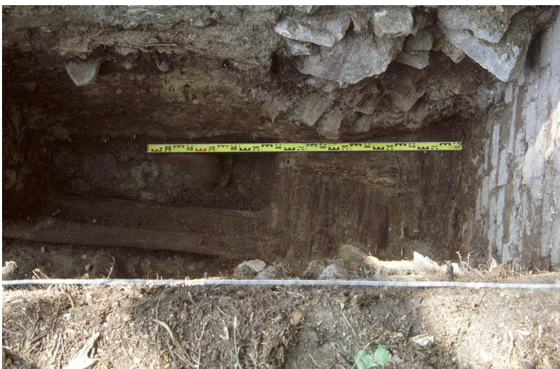
1800-luvun rakennuksen tiiliseinää ja puulattiaa. Kuva: HKM.
