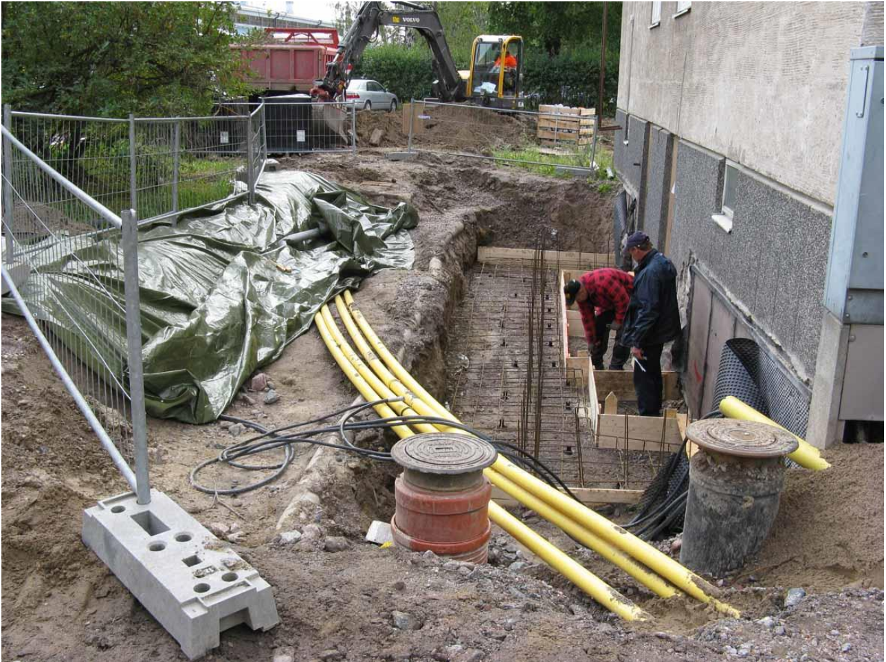
Rakennuksen 156b pohjoisseinusta lännestä kuvattuna vuonna 2010. Keltaiset telekaapelit on asennettu hiljakkoin ja nyt ovat menossa valupuuhat. Kuvassa etualalla näkyvät kaivot on asennettu ilmeisesti aiemmin. Kaivannon reunalla näkyy betonikourun suojaamia sähkökaapeleita. Kuva Heini Hämäläinen/HKM 26.8.2010. Kuvaussuunta W-E.
