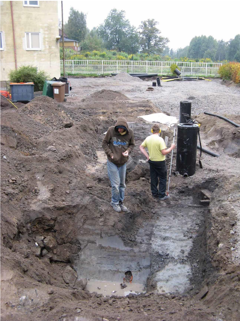
Kuvan alareunassa näkyy itä-länsi-suuntainen punasavikeraaminen putki, jonka kohdalla tumma maa sukeltaa syvemmälle. Idempi hirsi näkyy vaaleapaitaisen henkilön vieressä ja läntisempi hirsi hänen takanaan kuvaajaan nähden. Putken eteläpuolella (kuvassa vasemmalla puolella) oli alue, jossa oli kivistä täyttömaata. Kuva Heini Hämäläinen/HKM 14.9.2010. Kuvaussuunta E-W.
