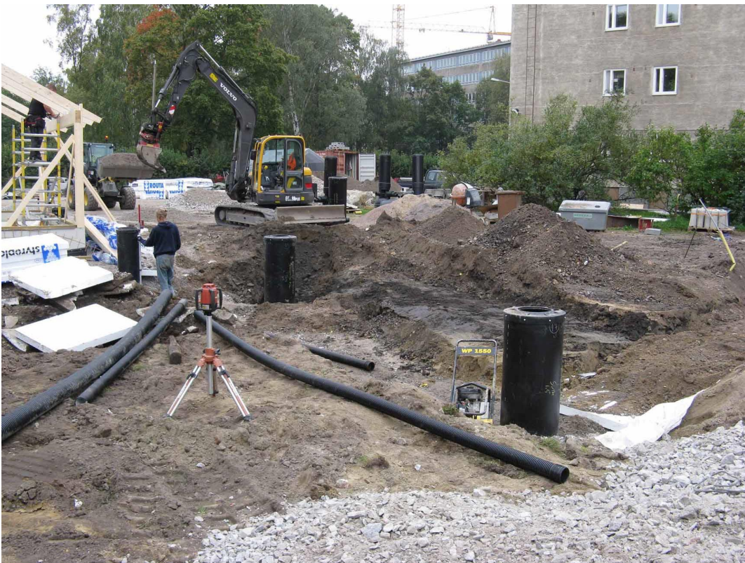
Yleiskuva pihan pohjoisosasta itäkaakkoon kuvattuna. Kuvan vasemmassa laidassa uusi roskakatos rakenteilla (vanhan paikalle). Uusia sadevesikaivoja ja putkia asennetaan. Taustalla näkyy koillisin rakennus 156b. Kuva Heini Hämäläinen/HKM 14.9.2010. Kuvaussuunta W-E.
