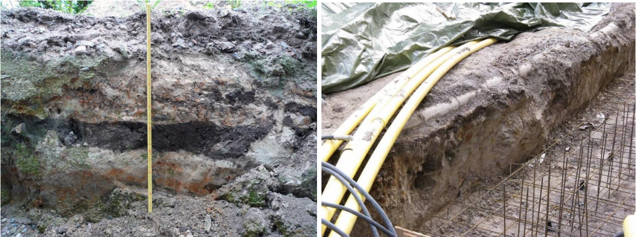
Kuvat ovat pohjoisprofiilista rakennuksen 156b pohjoisseinustalta. Vasemmanpuoleinen on vuoden 2007 Markku Heikkisen valvonnasta (Markku Heikkinen/HKM 25.5.2007. Kuvaussuunta S-N.) ja viereinen vuoden 2010 valvonnasta. Oikeanpuoleisesta kuvasta huomaa, että multakerros on sähkökaapeleiden kohdalta kaivettu pois ja puhtaan näköisen vaalean siltin päällä on vain kaapeleiden täyttömaata. Kuva Heini Hämäläinen/HKM 26.8.2010. Kuvaussuunta SW-NE.
