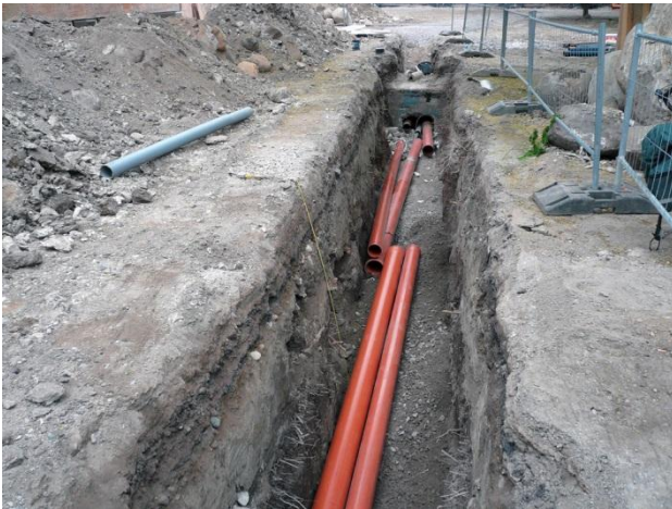
Hämeentie 156 2007. Edellinen kaivanto luoteeseen menevän tien länsipuolella. Havaintopiste 2 sijaitsee eteläprofiilissa mitan kohdalla ja havaintopiste 3 eteläprofiilissa ennen poikittaista betonitunnelia. Kuvaussuunta W. 25.5.2007.
