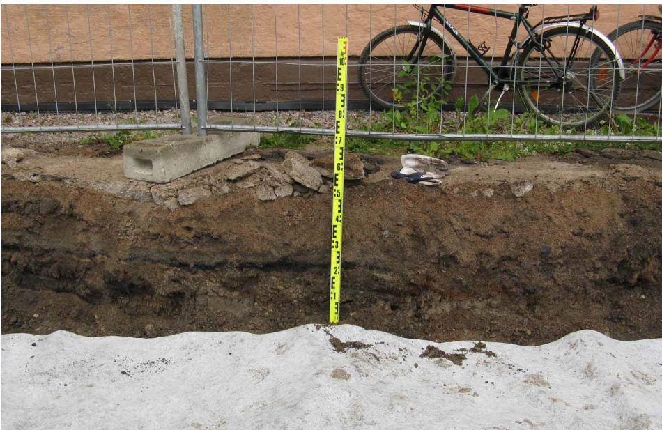
Rakennuksen 156a länsipuolen kaivantoa ja HP6. Kerroksissa on erilaisia täyttömaita. Kuvaussuunta W-E. Kuva H. Hämäläinen 7.7.2010.
