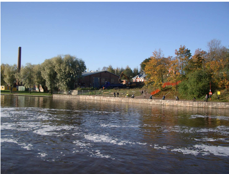
Tavi:n lisärakennuksen työmaa kuvattuna Kuninkaankartanonsaaresta. Kuvaussuunta SW. Kuva. HKM.
