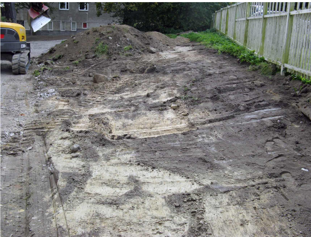
Rakennuksen 156d ja tontin läntisen raja-aidan välillä oleva alue maan poistamisen jälkeen. Taustalla rakennus 156c. Kuva Heini Hämäläinen/HKM 26.8.2010. Kuvaussuunta N-S.
