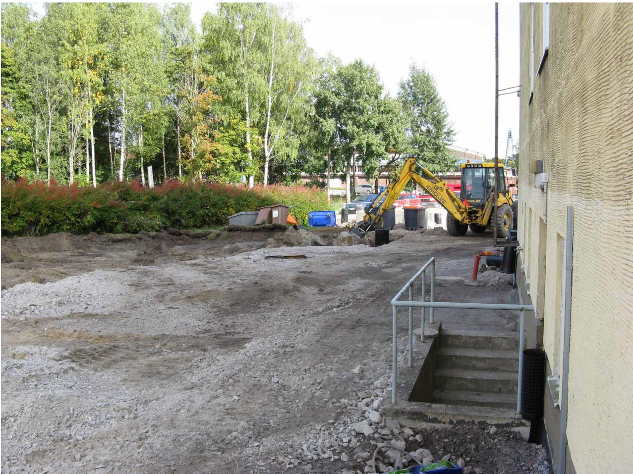
Rakennuksen Hämeentie 156d pohjoispuolta itään kuvattuna. Kuvassa alue, jota on käytetty parkkipaikkana. Alueelle on jo vaihdettu sorat ja uusia kaivoja ja sadevesiputkia ollaan asentamassa. Kuva Heini Hämäläinen/HKM 8.9.2010. Kuvaus-suunta W-E.
