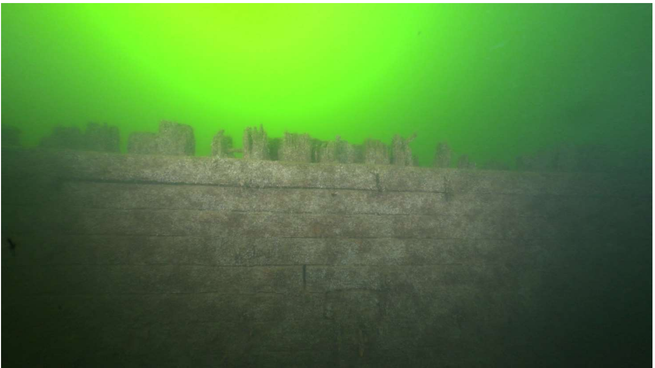
Kuva 14. Paapuurin puolen kylki keskilaivassa ulkopuolelta katsottuna.
