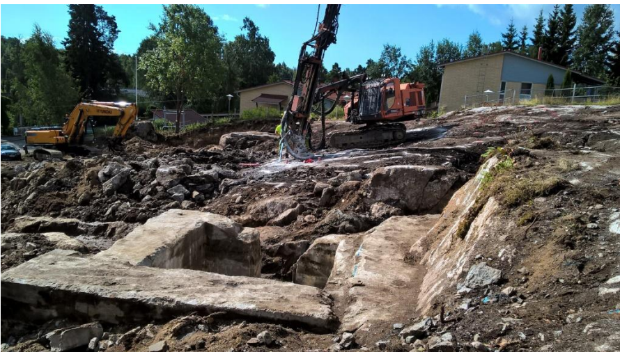
Rakennuksen puretun länsisiiven alta paljastui suojahuone II. Kallioporakoneen takana näkyy suojahuone III. Kuvaussuunta S. 3.8.2017. Kuva: Helsinki, Mellunkylä, Humikkalantie 58 2017:39.
