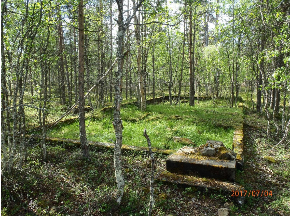
Rakennuksen pohja 1 etelään.
