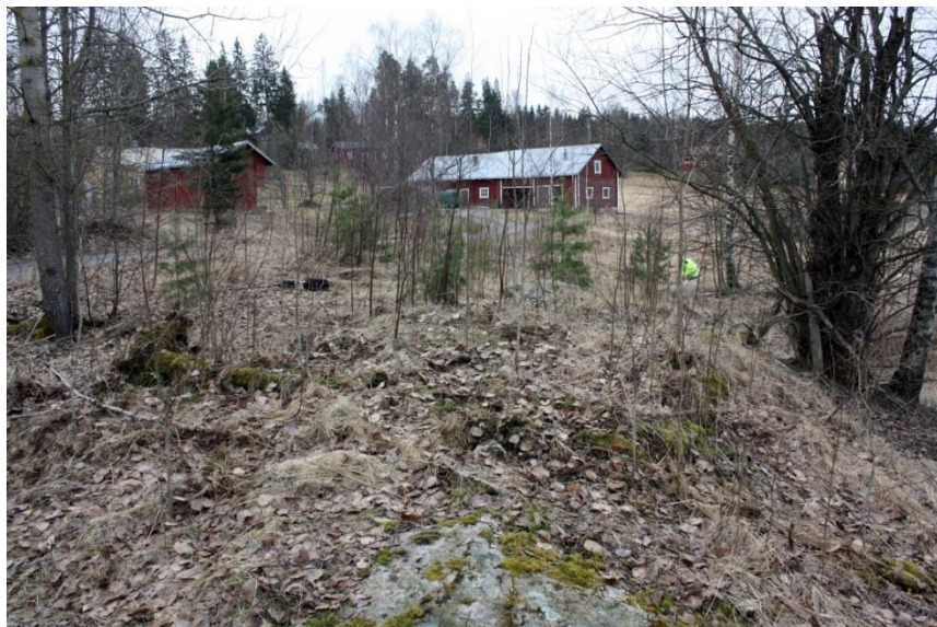
Kuva 7. Rakennusjännös R1, kuvattu pohjoisesta. AKDG 5268:7
