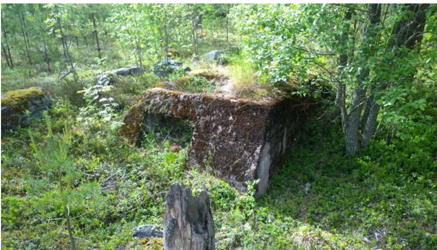
AKDG 5267:21. Talon vieressä oleva betonirakennelma. Kuvaaja: Petro Pesonen.
