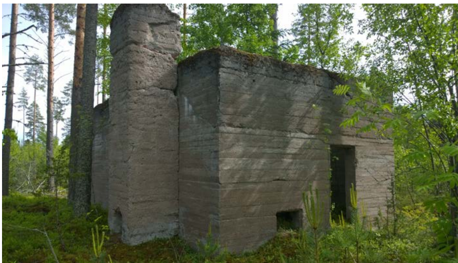
AKDG 5267:14. Betonitalon runko. Kuvaaja: Petro Pesonen.
