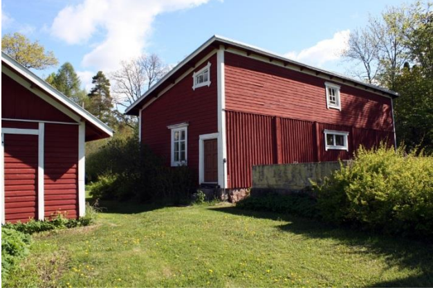
Kuva 3. Puutarhurin talo, kuvattu lounaasta. AKDG 5289:4
