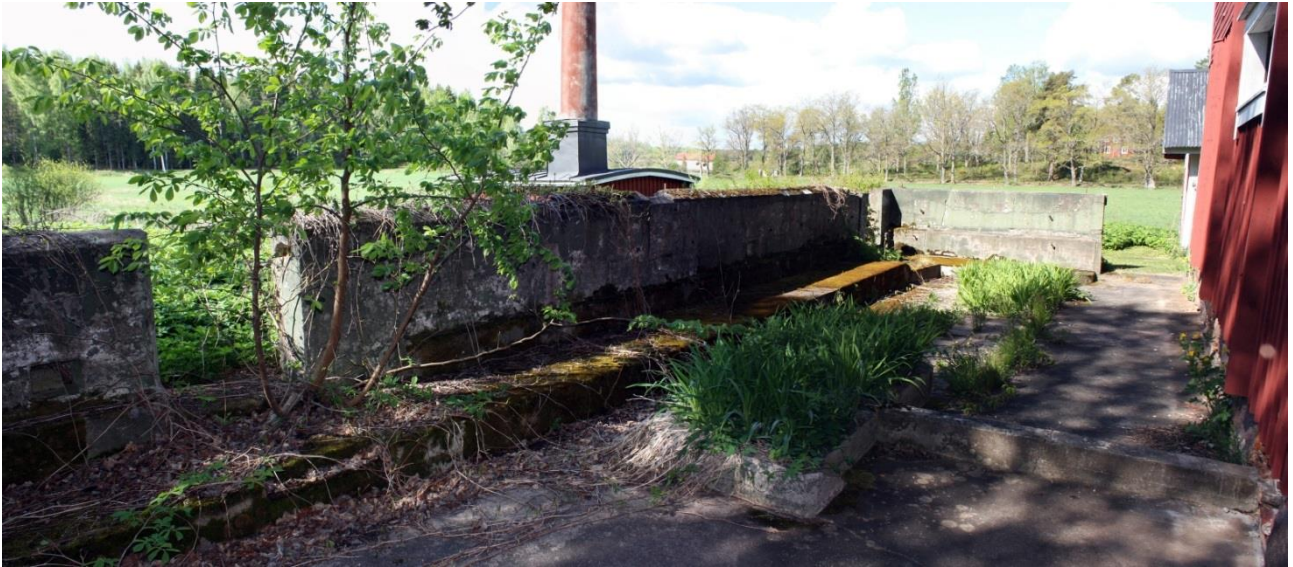
Kuva 5. Puutarhurin talon eteläpuolella oleva kasvihuoneen betoniperusta, kuvattu koillisesta. AKDG 5289:6
