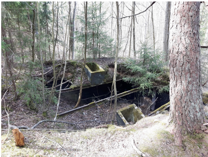
AKDG5220:18 Romahtanut kellari. SE-NW. Kuva Katja Vuoristo.
