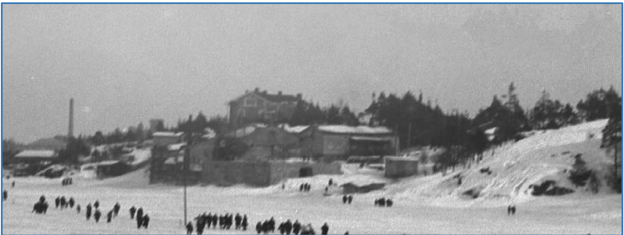
Kuva 2. Onkiniemen rannalla sijaitsevia teollisuusrakennuksia maaliskuussa 1928. Kuvassa näkyy ilmeisesti Onkiniemen panimon vuonna 1916 tyhjilleen jääneet rakennukset. Kuvaussuunta on kaakkoon. Kuvaaja Veikko Kanninen. Kuvalähde: Raninen 2014, kuvankäsittely ja rajaus S.Raninen. Kuvan säilytyspaikka Siiri-tietokanta AL 130:1.
