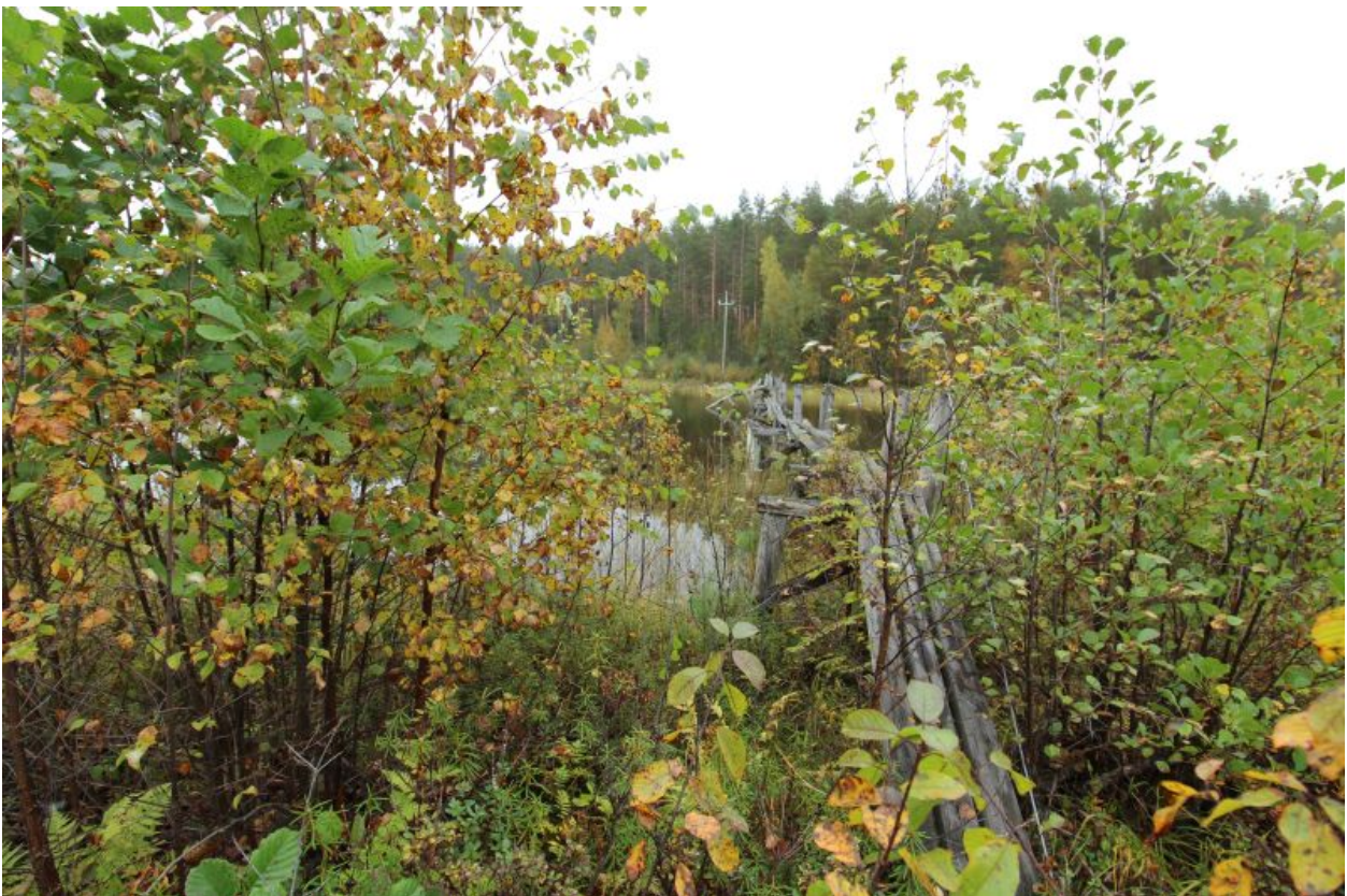
AKDG5293:96. Juva Tiutionsalmen silta. Kuvattu lounaasta. Kuva Esa Mikkola, Arkeologiset kenttäpalvelut.
