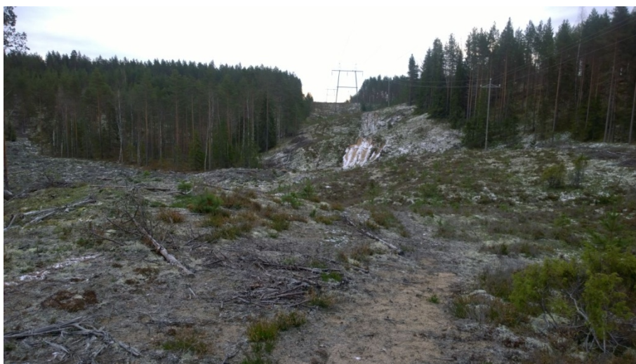
AKDG 5293:41. Avointa linjaa kumpuilevassa maastossa Rasviinlammen itäpuolella. Kuva: Petro Pesonen, Arkeologiset kenttäpalvelut.
