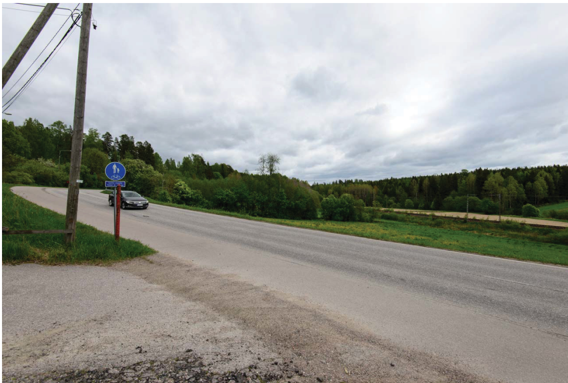
Espoo Suuri rantatie eli Kuninkaantie kulkee Espoonjoen länsipuolella nykyisen Iso maantien kohdalla. Suunniteltu ratalinja risteää Suuren rantatien kanssa kuvassa olevan risteyksen tuntumassa. Kuva lännestä. Kuva Vesa Laulumaa. (AKDG5221:1)
