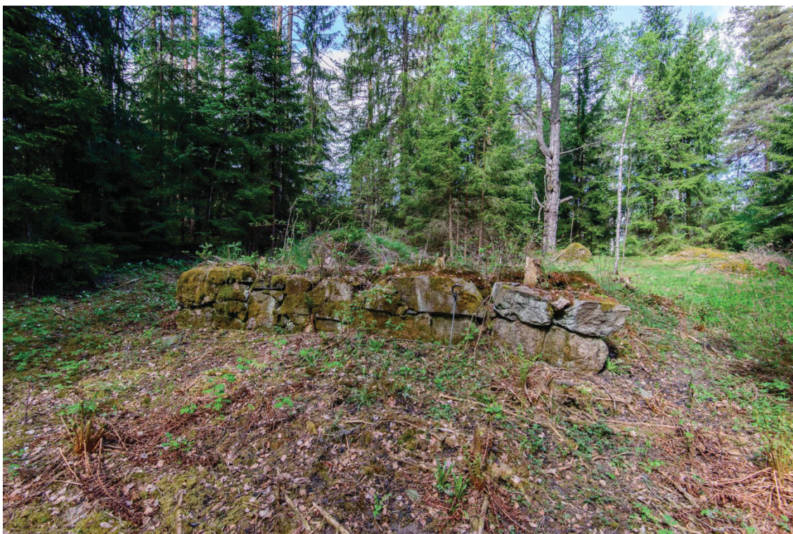
Lohja Raati. Rakennuksen rauniot mäen päällä. Kuva lännestä. Kuva Vesa Laulumaa. (AKDG5236:3)
