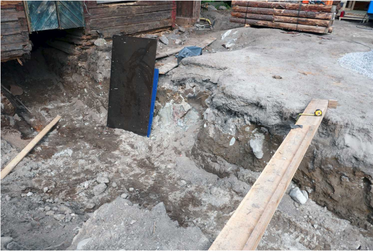
Kuva 171. Rakennusten välinen kaivanto. Pohjoisprofiilin länsiosa. Kuvaussuunta NW. 2.6.2016.
