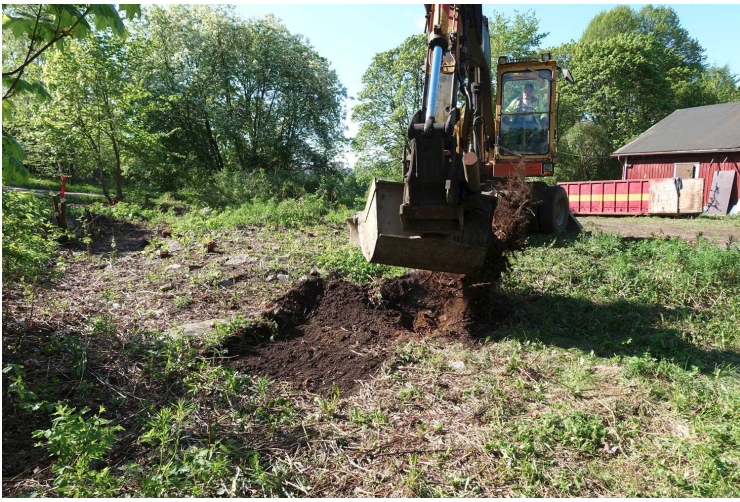
Kuva 42. Rakennus. Koneellinen kaavinta alkoi rakennuksen pohjoisalueen kaakkoisosasta. Kuvaussuunta SW. 17.5.2016.
