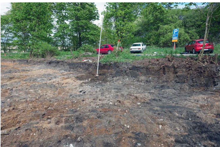
Kuva 73. Rakennus, havaintopiste R2. Sijaintikuva itäprofiilissa sijaitsevasta havaintopisteestä. Kuvaussuunta NE. 17.5.2016.
