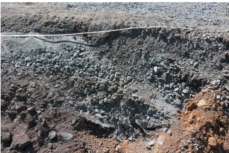
Kuva 132. Parkkipaikka. Alueen länsireunassa vanhan tien/parkkipaikan soran alla oli syvällä eristekangas moreenin päällä. Kuvaussuunta WSW. 2.8.2016.
