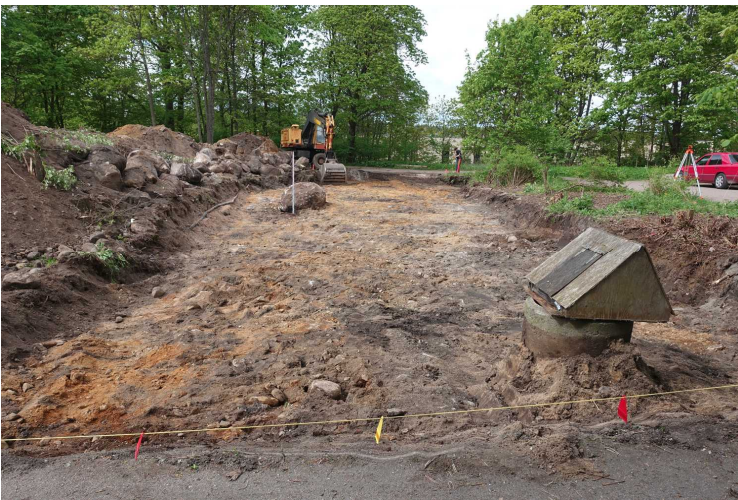
Kuva 68. Rakennus. Edellinen tilanne. Kuvaussuunta NNW. 17.5.2016.
