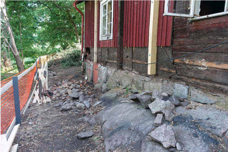
Kuva 180. Vanha rakennus. Rakennuksen länsisivun pohjoisosa. Kuvaussuunta N. 10.6.2016.
