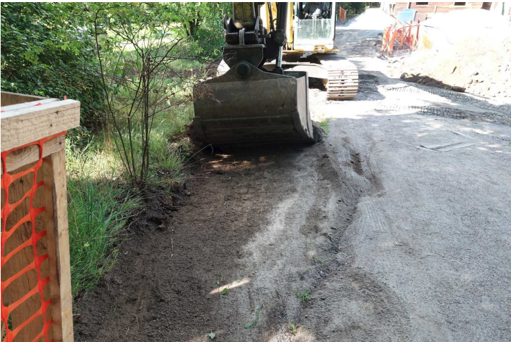
Kuva 144. Tie. Tielinjan siirtoalueen kaavinta alkoi ylhäältä idästä. Kuvaussuunta WSW. 2.8.2016.
