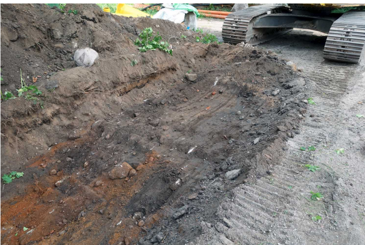
Kuva 154. Tie. Edellinen kohta syvemmäksi kaivettuna. Kuvaussuunta SW. 2.8.2016.
