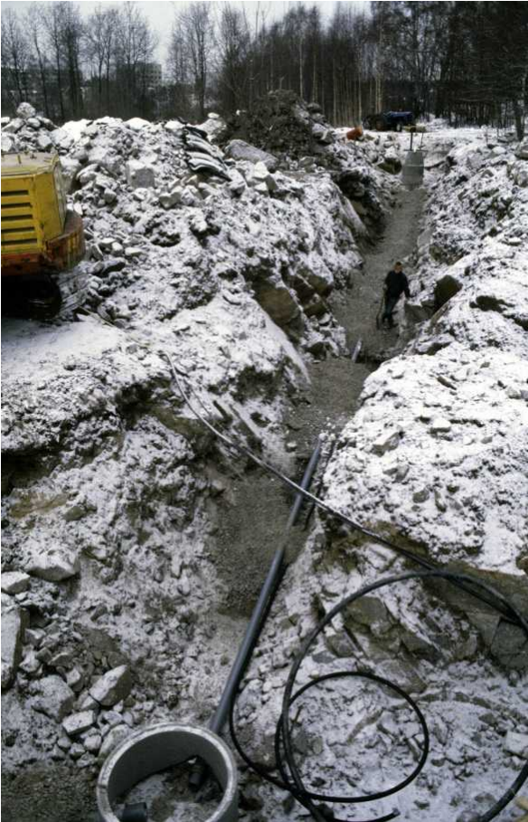
Vuoden 1987 viemärikaivanto Vanhankaupungintien eteläpuolella, jossa ylimpänä oli paksusti täytemaata ennen ohuempaa alkuperäistä maata. Poimukas kallio tuli usein lähes maanpinnalle saakka. Kuvaussuunta NW. Kuva: HKM.
