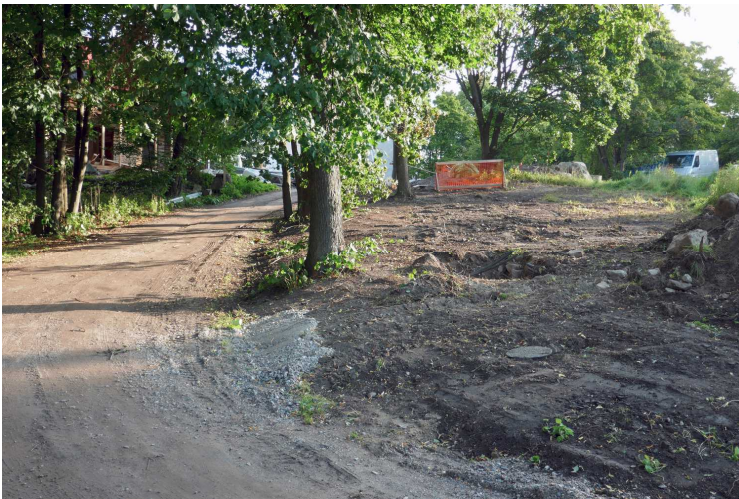
Kuva 192. Putkikaivanto. Kuvan 189 alue kuvattuna toisesta suunnasta. Putkikaivanto on peitetty. Kuvaussuunta NE. 20.8.2016.
