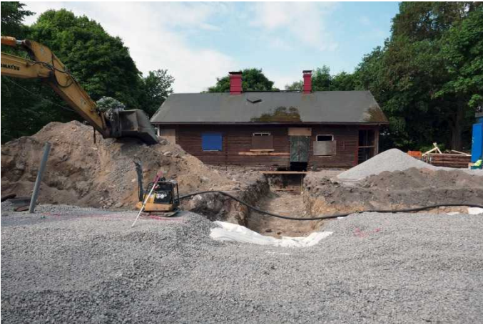
Rakennusten välinen kaivanto. Edessä näkyy uuden rakennuksen sorastettu alue. Kuvaussuunta WSW. 2.6.2016.
