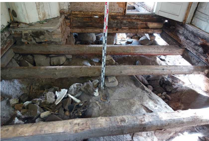
Vanha rakennus. Rakennuksen lounainen huone. Pohjalla on louhittua kalliota. Kuvassa näkyvät hirret ovat alapohjajavasoja. Lattia on sijainnut pari hirsikertaa korkeammalla. Lattiarakenne oli sama muissa huoneissa. Kuvaussuunta ENE. 10.6.2016.
