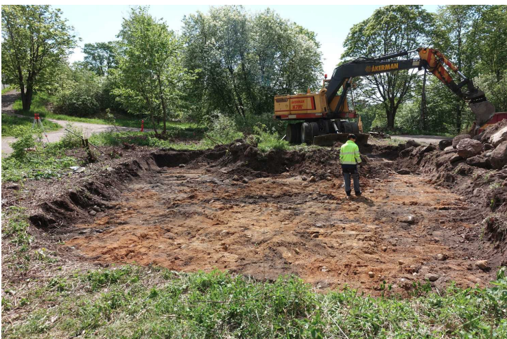
Kuva 53. Rakennus. Pohjoisalueen eteläosa ja suurin osa keskialueesta on kaivettu moreeniin saakka. Kuvaussuunta SSE. 17.5.2016.
