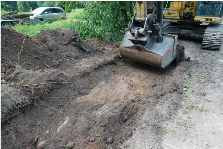
Kuva 149. Tie. Edellisen kohdan eteläpuolta kaavitaan. Kuvaussuunta SW. 2.8.2016.
