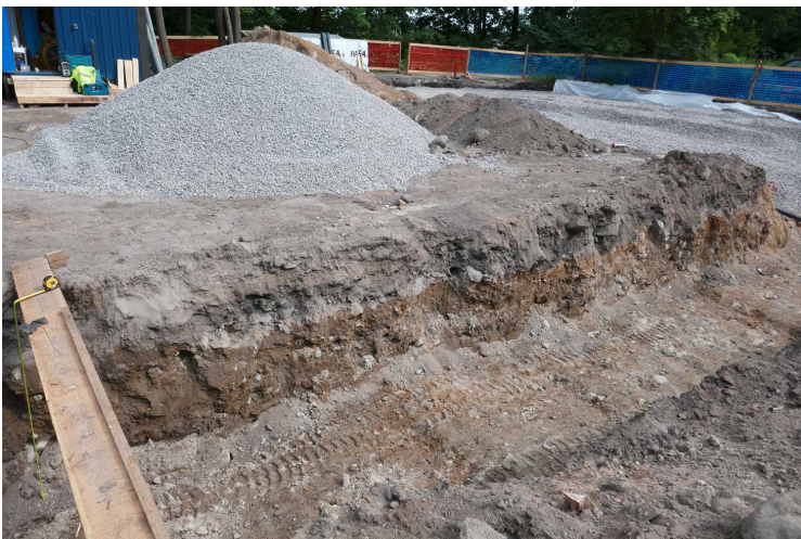
Kuva 170. Rakennusten välinen kaivanto. Pohjoisprofiilin itäosa. Kuvaussuunta NE. 2.6.2016.
