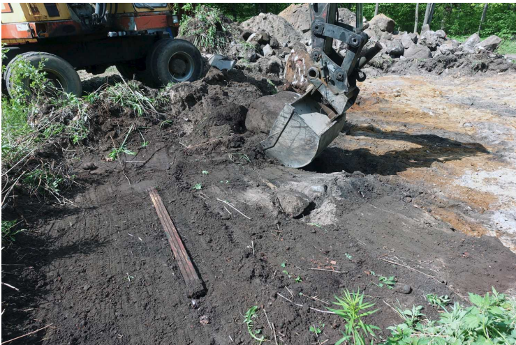
Kuva 55. Rakennus. Keskialueen kaakkoisosaa ja eteläalueen koillisosaa kaivetaan. Kuvaussuunta NWE. 17.5.2016.
