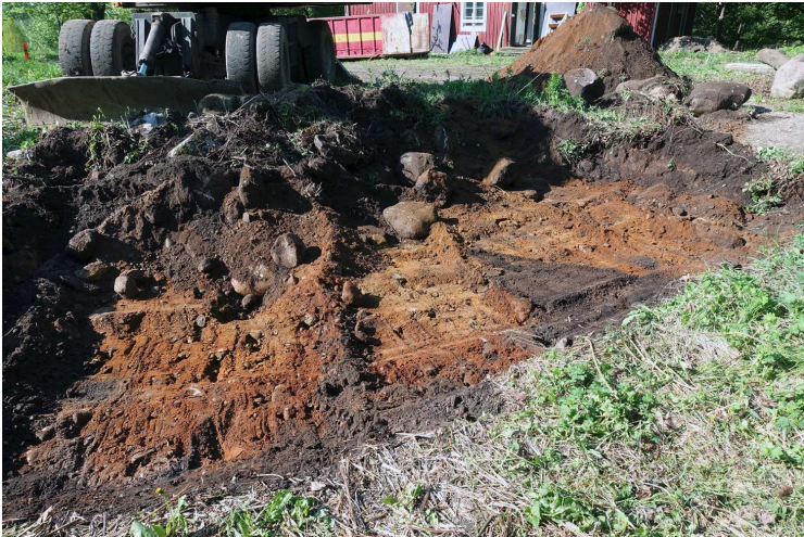
Kuva 43. Rakennus. Pohjoisalueen kaakkoisosassa ja keskialueen koillisosassa on kaivettu kerroksittain luonnolliseen moreeniin saakka. Kuvaussuunta WSW. 17.5.2016.
