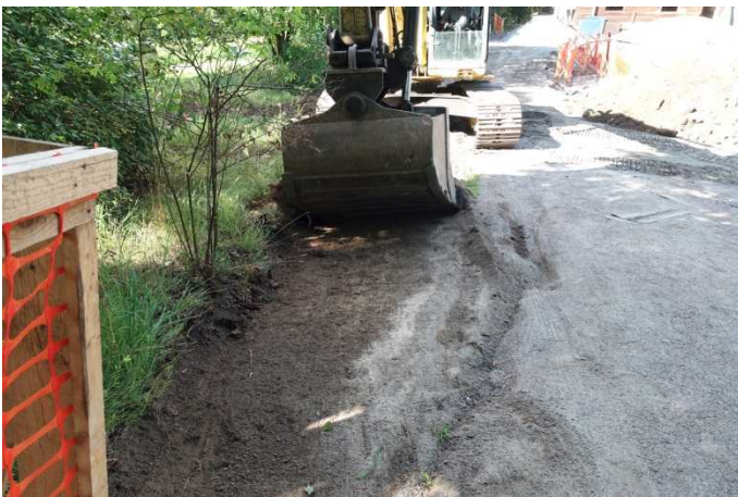
Tie. Tielinjan siirtoalueen kaavinta alkoi ylhäältä idästä. Kuvaussuunta WSW. 2.8.2016.
