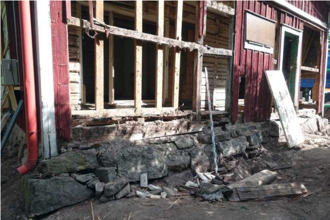
Vanha rakennus. Rakennuksen eteläsivu. Kivijalka on kallion päällä. Kallion päältä on poistettu multakerros. Kuvaussuunta NE. 10.6.2016.
