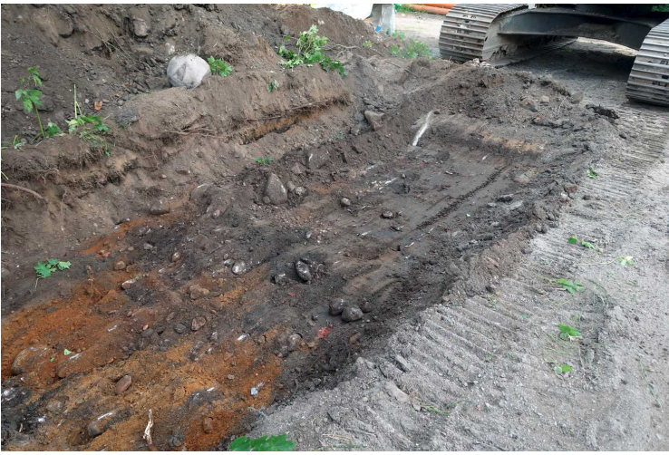
Kuva 155. Tie. Edellinen kohta edelleen syvemmäksi kaivettuna. Kuvaussuunta SW. 2.8.2016.
