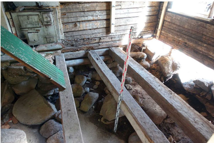
Kuva 184. Vanha rakennus. Rakennuksen kaakkoinen huone. Vasemmassa alanurkassa näkyy kallio. Muualla on hiekkaa pohjalla. Kuvassa näkyvät hirret ovat alapohjajvasoja. Lattia on sijainnut pari hirsikertaa korkeammalla. Lattiarakenne oli sama muissa huoneissa. Kuvaussuunta N. 10.6.2016.
