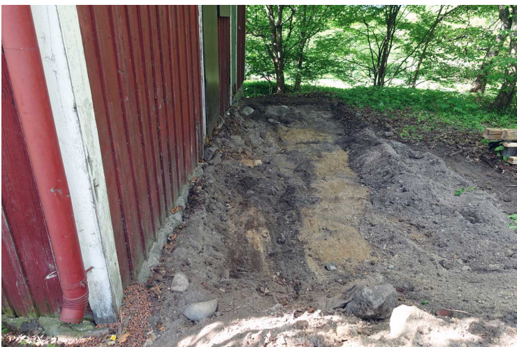
Kuva 182. Vanha rakennus. Rakennuksen pohjoissivu rakennustöiden alkuvaiheessa. Kuvaussuunta WSW. 17.5.2016.
