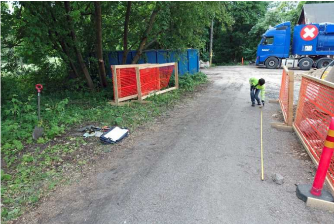
Tie. Koekuoppa T1 sijaitsi vasemmalla maassa olevien tarvikkeiden takana. Uuden tontin raja sijaitsi mitan kohdalla. Tietä täytyi siirtää kaksi metriä etelään päin, vasemmalle, tämän vuoksi. Kuvaussuunta WSW. 9.6.2016.
