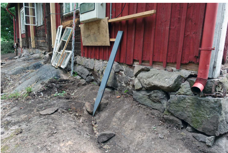
Kuva 179. Vanha rakennus. Rakennuksen länsisivun eteläosa. Muurattu kivijalka on suurimmaksi osaksi kallion päällä. Rakennuksen lounaisnurkan edestä on poistettu kallion päällä ollutta multaa. Taaempänä näkyvä kallio on ollut esillä. Kuvaussuunta N. 10.6.2016.
