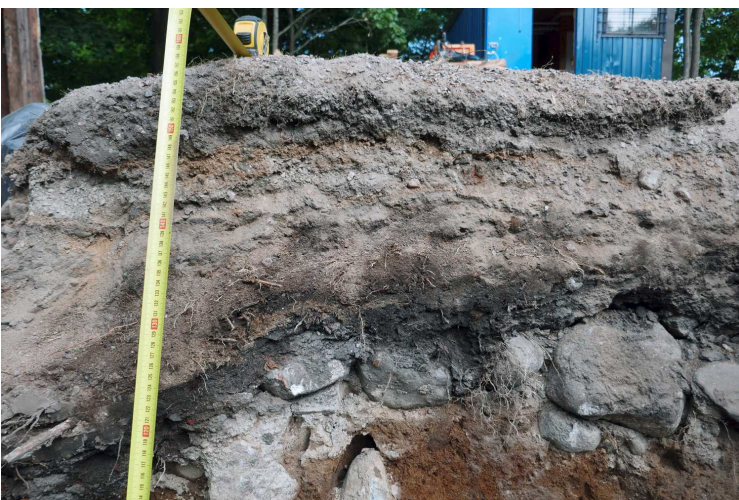
Kuva 173. Rakennusten välinen kaivanto, havaintopiste K1. Lähikuva havaintopisteen yläosasta. Kuvaussuunta NNW. 2.6.2016.
