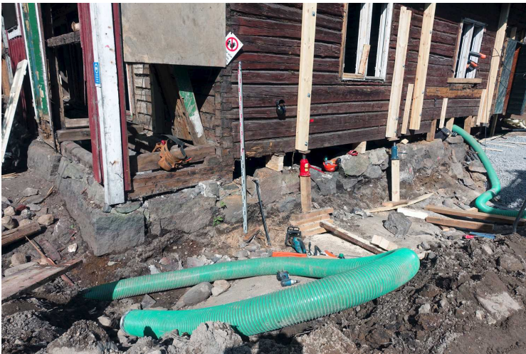
Kuva 177. Vanha rakennus. Rakennuksen kaakkoiskulma. Itäseinän huonokuntoinen kivijalka on moreenin päällä. Ulkopuolella näkyy kaivannossa kallio. Kuvaussuunta NW. 10.6.2016.
