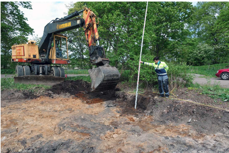
Kuva 75. Rakennus, havaintopiste R3. Sijaintikuva itäprofiilissa sijaitsevasta havaintopisteestä. Kuvaussuunta NE. 17.5.2016.
