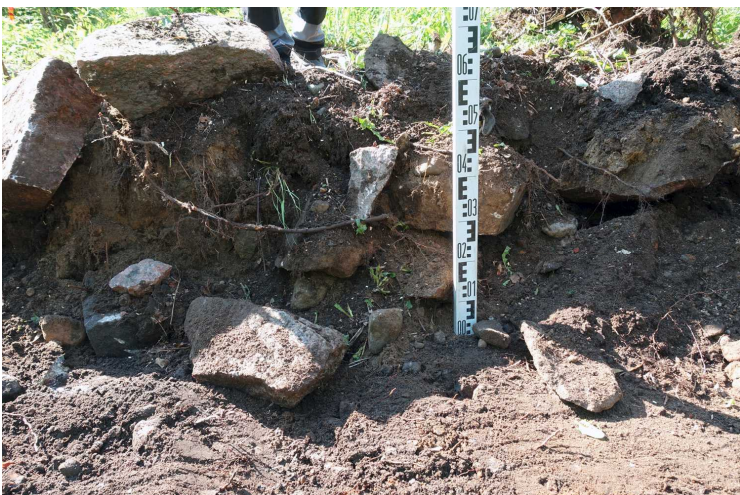
Kuva 45. Rakennus. Lähikuva edellisestä kohdasta hetkeä myöhemmin. Kuvaussuunta SSW. 17.5.2016.
