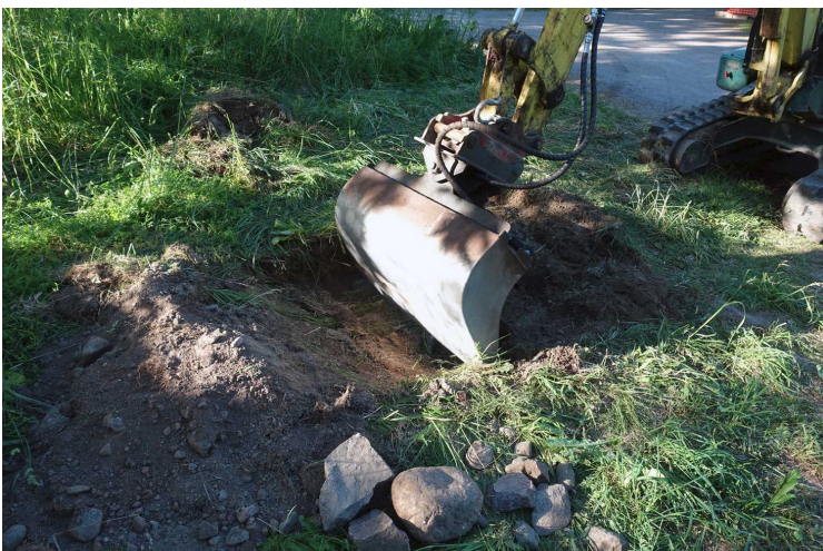
Kuva 108. Parkkipaikka, koekuoppa P4. Yhteyden 5 kivikerros jouduttiin poistamaan koneellisesti. Kuvaussuunta S. 10.6.2016.
