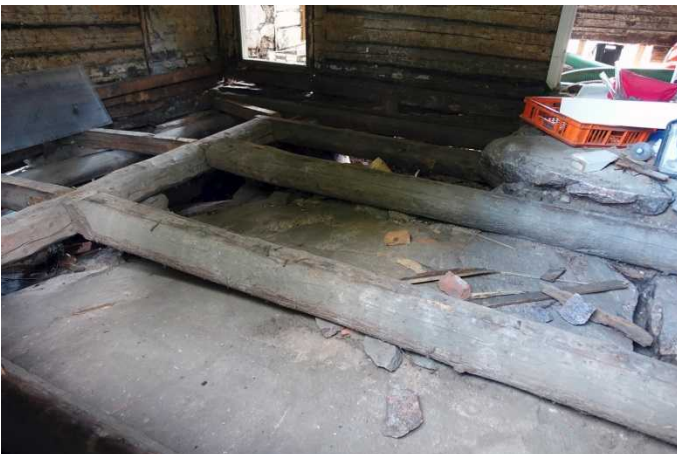
Vanha rakennus. Rakennuksen länsipuolen keskinen huone. Kallio ulottuu lattiapohjajavasoihin saakka. Kuvaussuunta NE. 10.6.2016.
