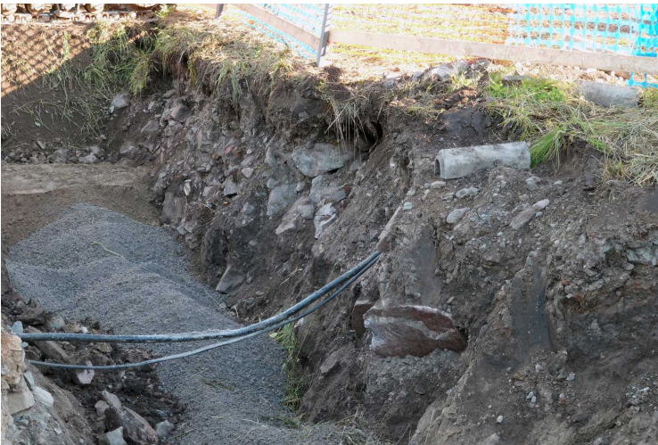
Kuva 196. Putkikaivanto. Edellinen kohta. Kaivannon itäprofiilissa näkyy vain kaivannon täyttömaita (mm. kallioulouhetta). Kuvaussuunta N. 20.8.2016.
