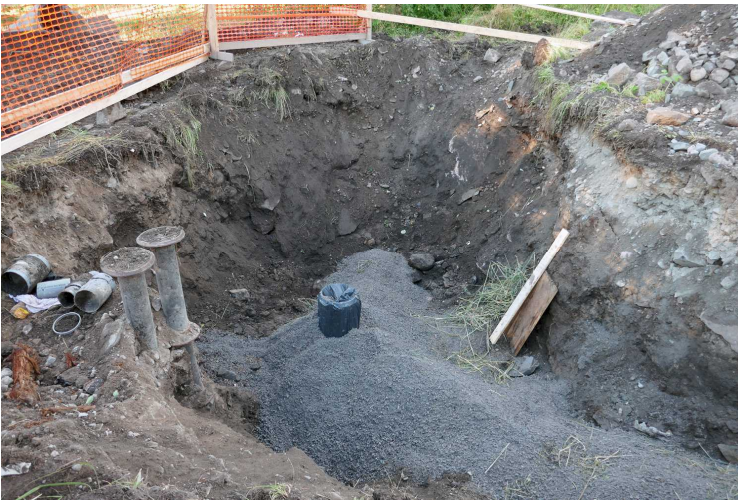
Kuva 194. Putkikaivanto. Kaivanto valvonta-alueelta oikealta ja Johannesbergista vasemmalta tulevien putkien yhtymäkohdassa uudistetun putkiosuuden eteläpäässä. Kuvaussuunta S. 20.8.2016.
