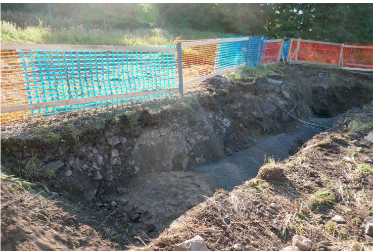
Kuva 197. Putkikaivanto. Edellinen tilanne. Kuvaussuunta E. 20.8.2016.
