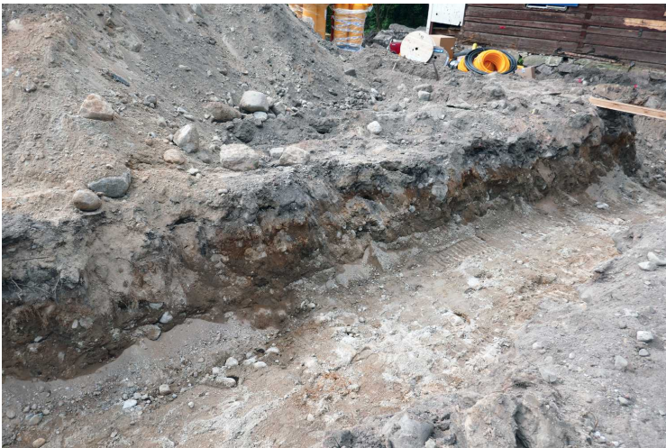
Kuva 168. Rakennusten välinen kaivanto. Eteläprofiili. Pintamaata on kaivettu pois. Kuvaussuunta SW. 2.6.2016.
