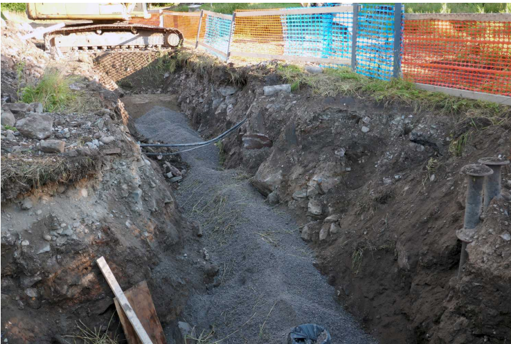
Kuva 195. Putkikaivanto. Kaivanto edellisestä kohdasta länteen päin. Kuvaussuunta NNW. 20.8.2016.
