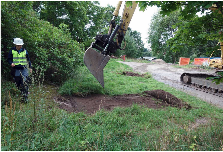
Kuva 113. Parkkipaikka. Alueen kaavinta alkoi pohjoispäästä. Kuvaussuunta SSE. 2.8.2016.
