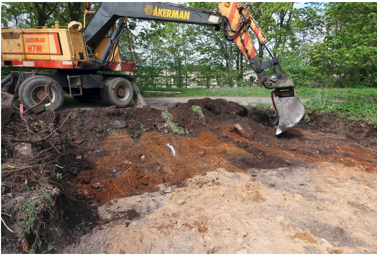
Kuva 62. Rakennus. Pohjoisalueen pohjoisosa. Kuvaussuunta NE. 17.5.2016.
