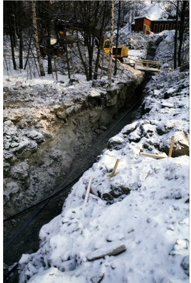
Kaivanto Vanhankaupungintien eteläpuolelta tien poikki Johannesbergiin. Ohuen pintakerroksen jälkeen profiilissa oli kalliota tai soraa. Taustalla näkyy Johannesbergin nykyisin purettu ulkorakennus. Kuvaussuunta NE. Kuva: HKM.
