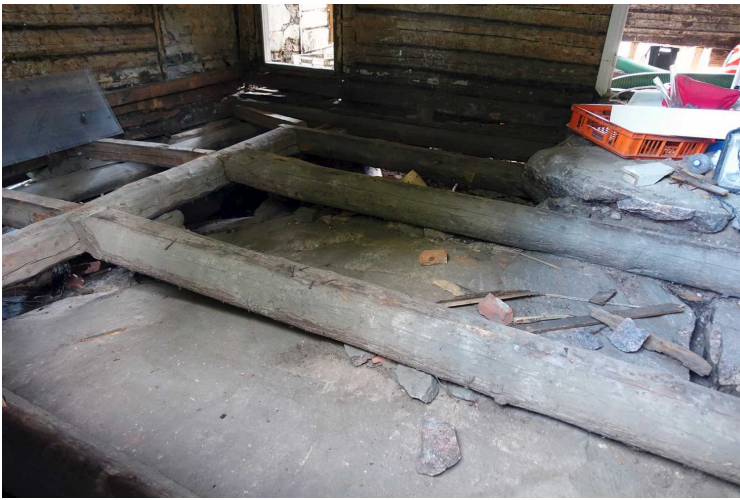
Kuva 186. Vanha rakennus. Rakennuksen länsipuolen keskinen huone. Kallio ulottuu alapohjajasoihin saakka. Kuvaussuunta NE. 10.6.2016.
