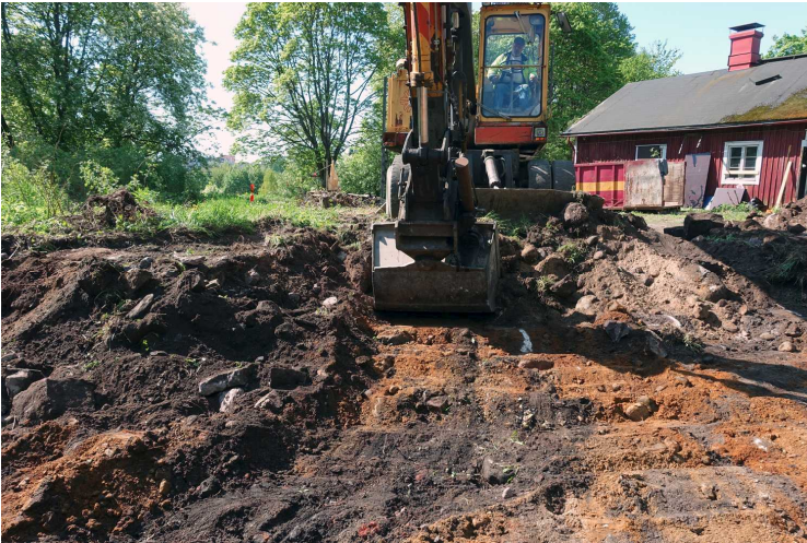
Kuva 48. Rakennus. Edellinen kohta hiukan myöhemmin. Lohkokivien määrä alkaa vähentyä. Kuvaussuunta SW. 17.5.2016.
