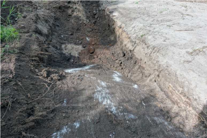
Tie. Multa ja tien hiekkakerrosten alta etualan kallion länsipuolelta alkaa tulla esiin luonnollinen kellanruskea moreenikerros. Kuvaussuunta WSW. 2.8.2016.
