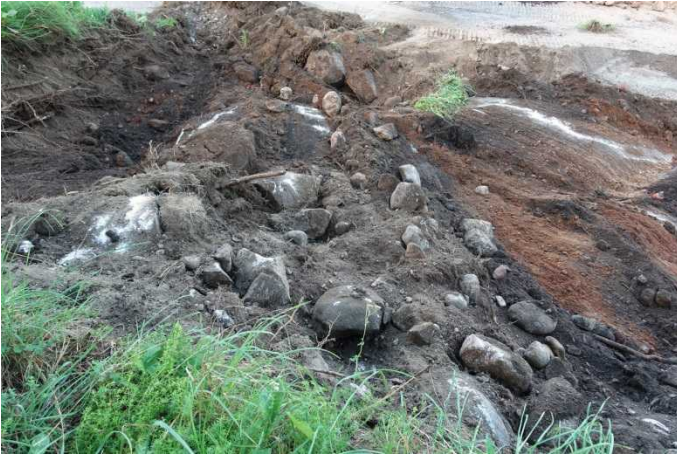
Parkkipaikka. Alueen eteläosa. Kuvassa kallion ja moreenin päällä on vielä tumman multakerroksen päällä ollutta kivitäytettä. Kuvaussuunta SW. 2.8.2016.
