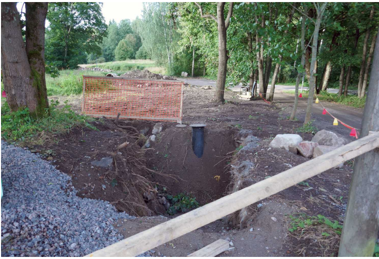
Kuva 190. Putkikaivanto. Vuoden 1978 putkikaivannon pohjoispää Vanhankaupungintieltä tulevan tien eteläpuolella. Putket on jo uudistettu ja kaivanto täytetty. Kuvaussuunta SW. 20.8.2016.
