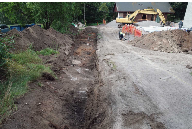
Kuva 158. Tie. Kaivanto kuvattuna idästä käsin. Edessä näkyy kallioalue. Kuvaussuunta WSW. 2.8.2016.
