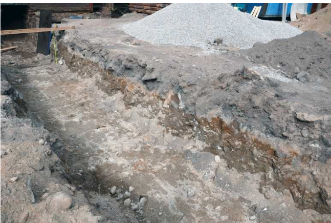
Rakennusten välinen kaivanto. Pohjoisprofiili. Kuvaussuunta WNW. 2.6.2016.
