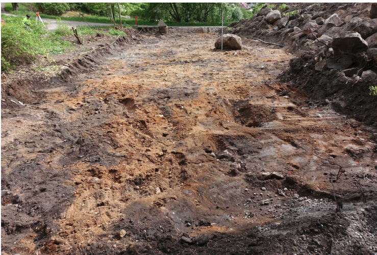
Kuva 64. Rakennus. Alue kaavinnan valmistuttua. Kuvaussuunta SSE. 17.5.2016.
