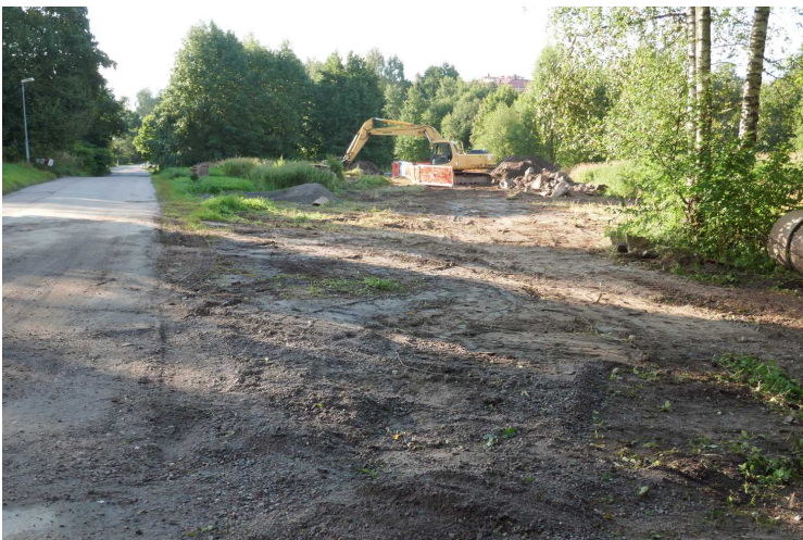
Kuva 193. Putkikaivanto. Kaivanto Vanhankaupungintien eteläpuolella. Pohjoispää on peitetty. Kuvaussuunta SSE. 20.8.2016.
