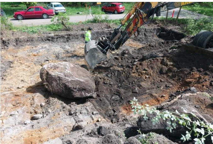
Rakennus. Keskialueen lounaisosa. Ylös kaivetun ison kiven eteläpuolella oli uudempaa sekoittunutta maata syvemmälle. Kuvaussuunta ESE. 17.5.2016.
