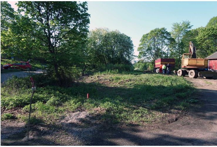
Kuva 38. Rakennus. Alue koneellisen kaavinnan alkaessa. Suurin osa puista on kaadettu. Kuvaussuunta SE. 17.5.2016.
