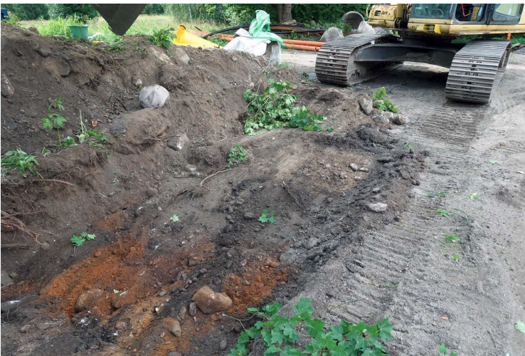
Kuva 153. Tie. Kaivannon eteläpää. Kuvaussuunta SW.2.8.2016.
