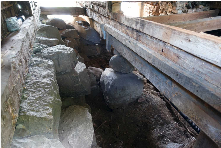
Kuva 187. Vanha rakennus. Rakennuksen pohjoispään kapea lautarakenteinen osa. Kuvaussuunta ENE. 10.6.2016.
