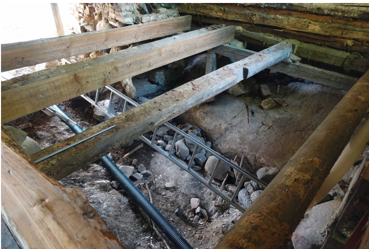
Kuva 188. Vanha rakennus. Rakennuksen luoteinen huone. Eteläosassa näkyy kalliota. Kuvaussuunta ESE. 10.6.2016.
