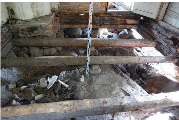
Kuva 185. Vanha rakennus. Rakennuksen lounainen huone. Pohjalla on louhittua kalliota. Kuvaussuunta ENE. 10.6.2016.
