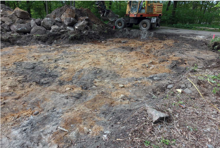
Kuva 67. Rakennus. Edellinen tilanne. Alueen pohjoisosa ja osa keskialueesta. Luoteisin osa kaivinkoneen edessä jäi kaivamatta. Kuvaussuunta NW. 17.5.2016.
