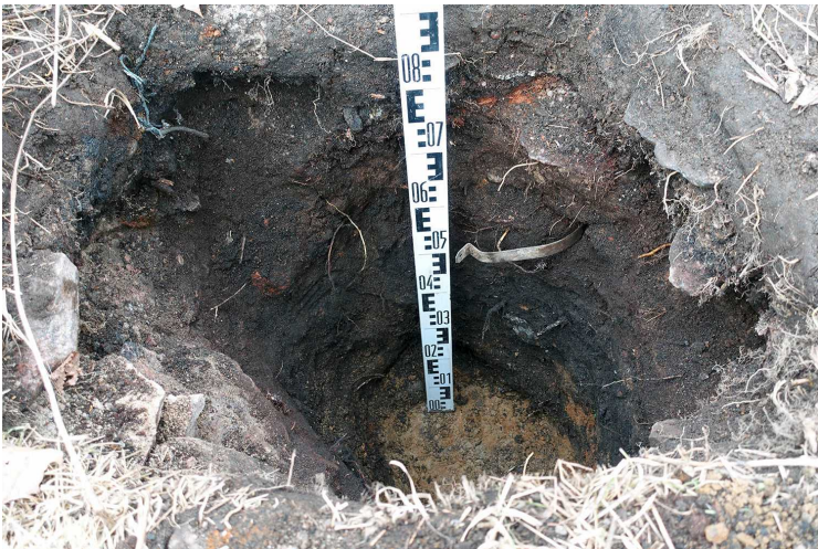
Kuva 23. Rakennus, koekuoppa R2. Koekuopan luoteisnurkan profiili. Kuvaussuunta SW. 1.4.2016.
