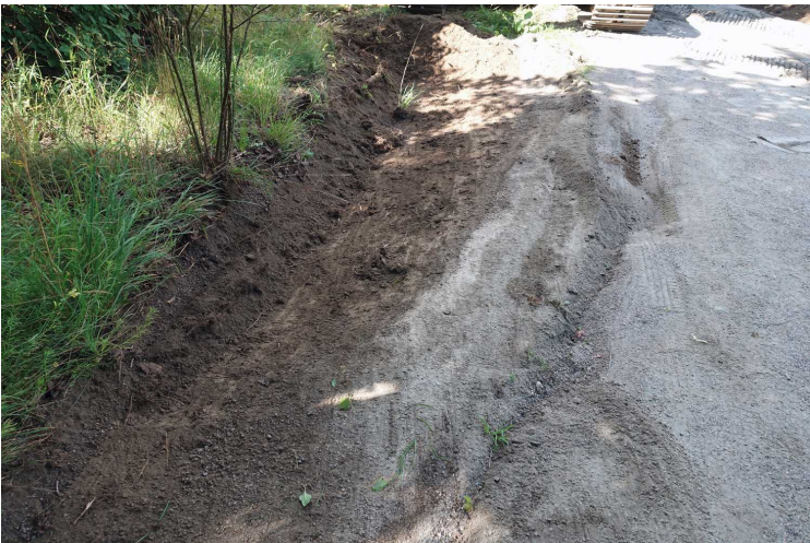
Kuva 145. Tie. Kaavintakohtasta tuli tien reunalla tien sorakerroksia ja eteläpuolella multaa ennen kalliota. Kuvaussuunta WSW. 2.8.2016.
