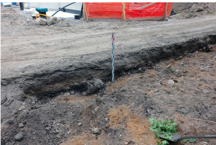
Kuva 162. Tie. Kaivannon pohjoisprofiilin länsipää. Länsipäässä oli alimpana profiilin tummin kerros. Kuvaussuunta ENE. 2.8.2016.
