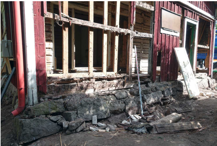
Kuva 178. Vanha rakennus. Rakennuksen eteläsivu. Kivijalka on kallion päällä. Kallion päältä on poistettu multakerros. Kuvaussuunta NE. 10.6.2016.
