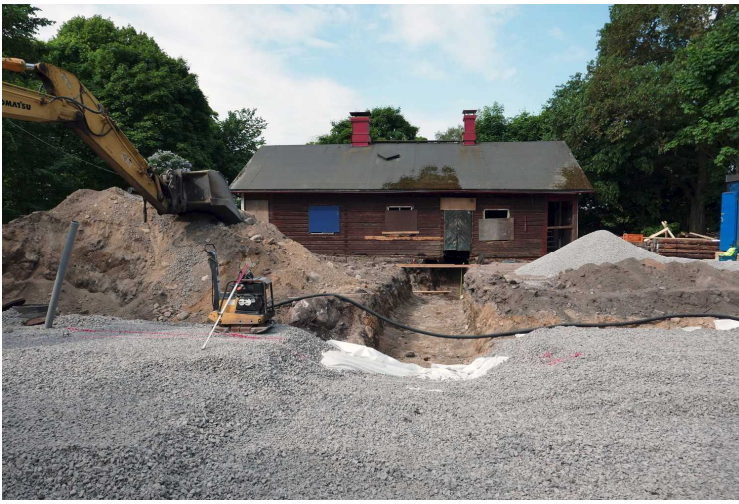
Kuva 167. Rakennusten välinen kaivanto. Edessä näkyy uuden rakennuksen sorastettu alue. Kuvaussuunta WSW. 2.6.2016.
