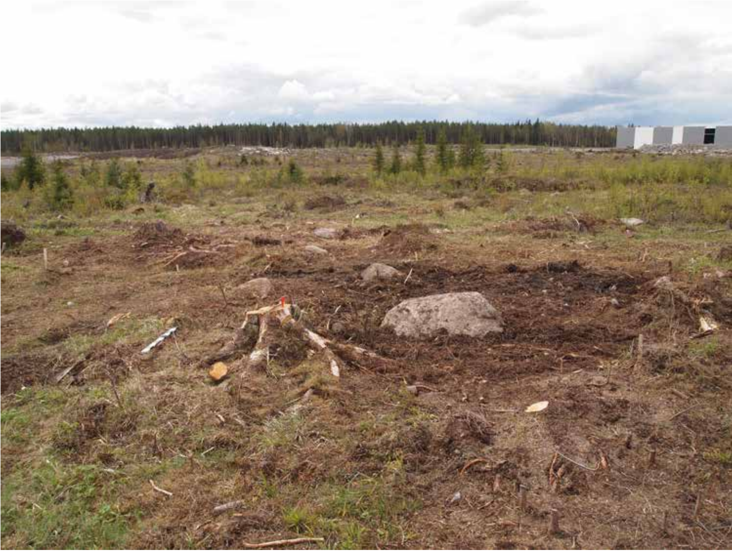
285. Alue C1, turve osin poistettu. N. M.Helamaa. 18.5.2015.
