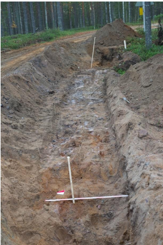
SKDG 201610:29 Alue 4 ennen tasokaivauksen aloittamista. Kuvattu kohti itää.
