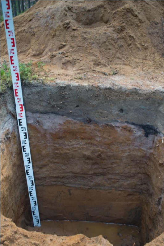
SKDG 201610:13 Alue 1. Kaakkoisprofiili. tarkistuskuopan kohdalla. Profilissa päällimmäisenä erottuu harmaa tiekerros, jonka alla on vanha maanpinta. Alempana erottuu alin maanpinta ja siihen liittyvä hyvin ohut huuhtoutumiskerros. Kuopan pohjalla on vettä.
