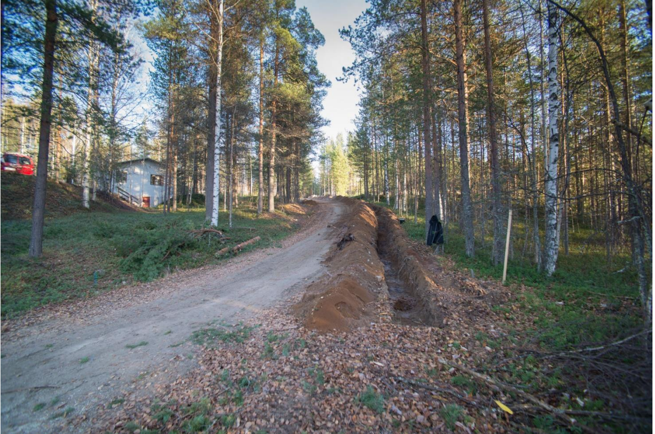
SKDG 201610:48 Valvotun kaivannon länsipääty (lähimpänä voimalaitosta). Taustalla vasemmalla erottuu voimalaitoksen huoltorakennuksen pääty. Kuvattu kohti itää.
