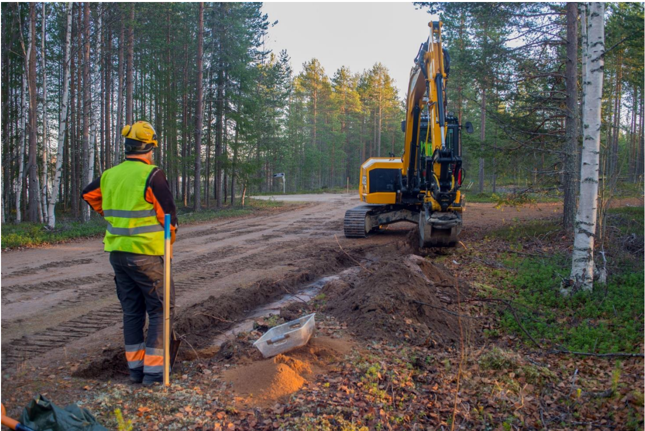
SKDG 201610:5 Esa Haataja valvoo tiekerroksen poistoa kaivinkoneella Kaaraneskoskentien ja kohteen Kaaranes 3 välisellä osuudella. Taustalla erottuu Kaaraneskoskentien risteys. Kuvattu kohti kaakkoa.
