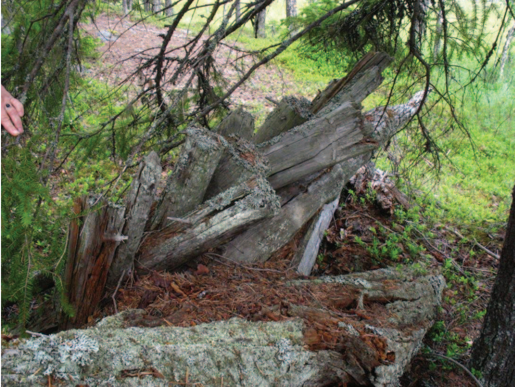
Kuva 255: Osa kattorakenteista on säilynyt.
