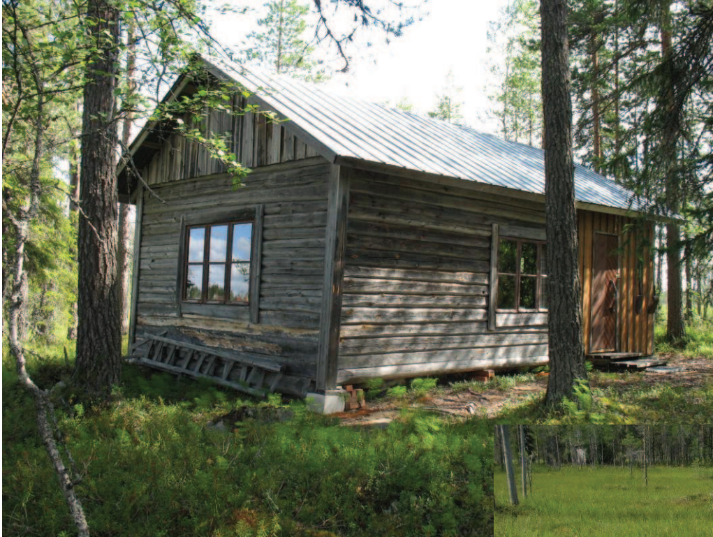
Kuva 207: Heinälammen valvontatupa kuvattuna lounaasta.
