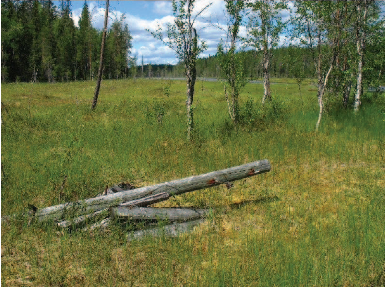
Kuva 240: Maahan kaatunut puhelinpylväs. Kuvattu idästä
