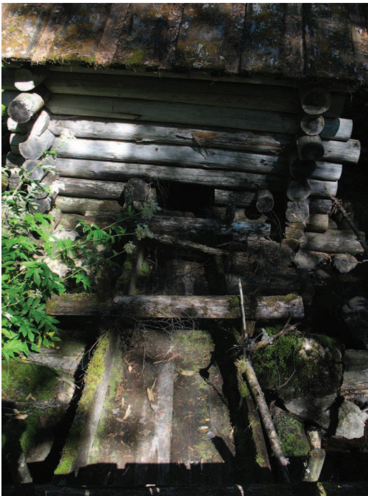
Kuva 203: Kotijoen vesimylly kuvattu länsiluoteesta.
