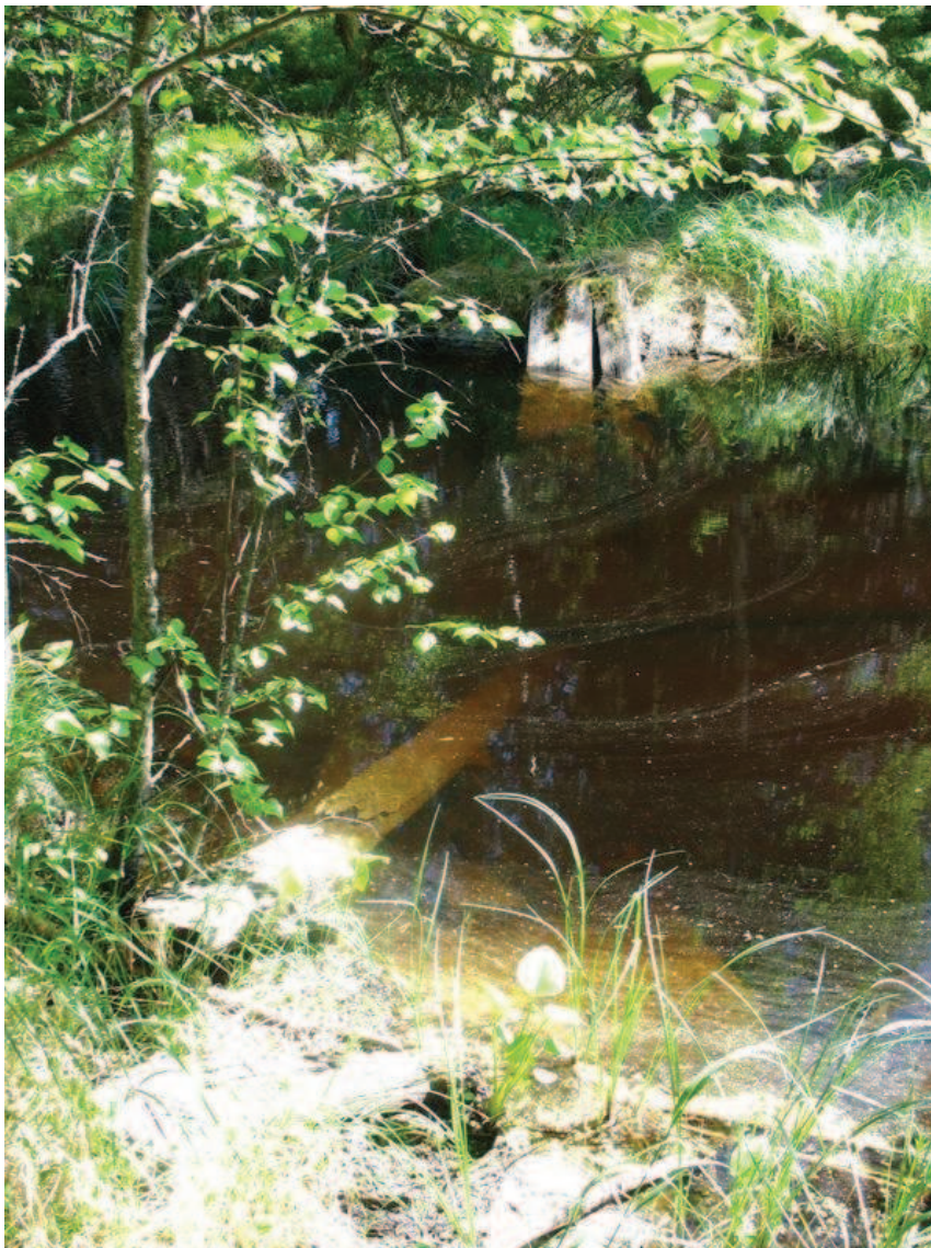
Kuva 112: Kuvassa sillanjäänteet. Kuvattu länsiluoteesta.
