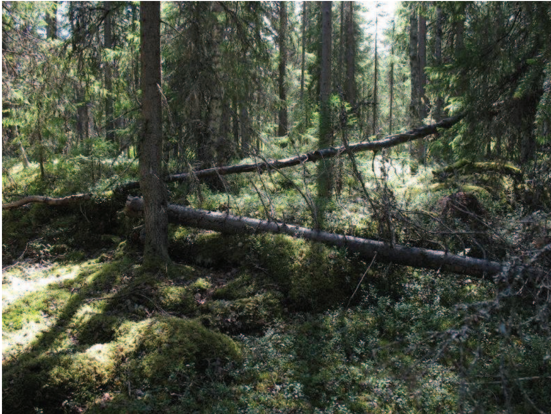
Kuva 187: Rakennusjäännöksen päälle on kaatunut puita. Kuvattu koillisesta.
