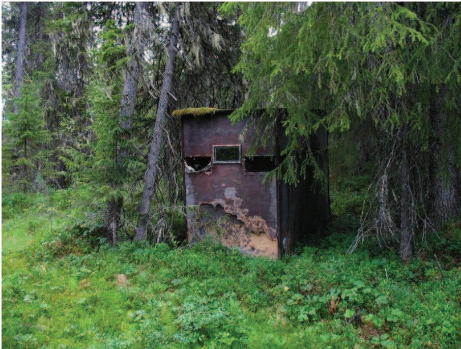
Kuva 257: Rakennusjäännös edestä kuvattuna. Siinä on tasakatto ja kolme pientä ikkunaa. Kuvattu luoteesta.
