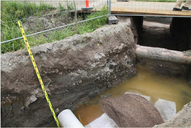
Kuva 16. Kuten edellä. Kaivannon koillisosaa Strandmaninkujalla. Kaivannon 'penkan puolella' kaakkoisprofiilissa havaittiin savihiekkaa ja karkeaa hiekkaa luonnollisen saven päällä. Kuvaussuunta S. Kuva Heini Hämäläinen/HKM 25.6.2013.
