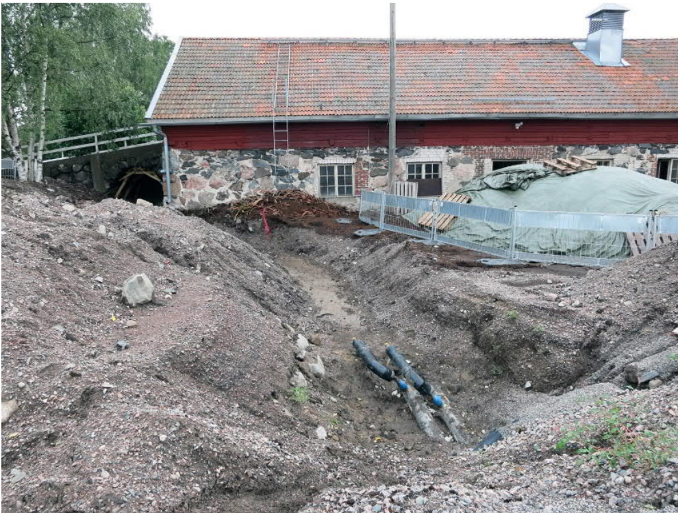
Kuva 47. Tallit. Elokuussa kaivantoa jatkettiin aukion pohjoislaidassa olevaan talousrakennukseen-talliin (rakennus 19). Vanhoista putkista vedettiin uusi linja rakennuksen länsipäähän. Etualalla on uusien putkien liitoskohta. Kuvaussuunta NNW. Kuva Markku Heikkinen/HKM 29.8.2014.
