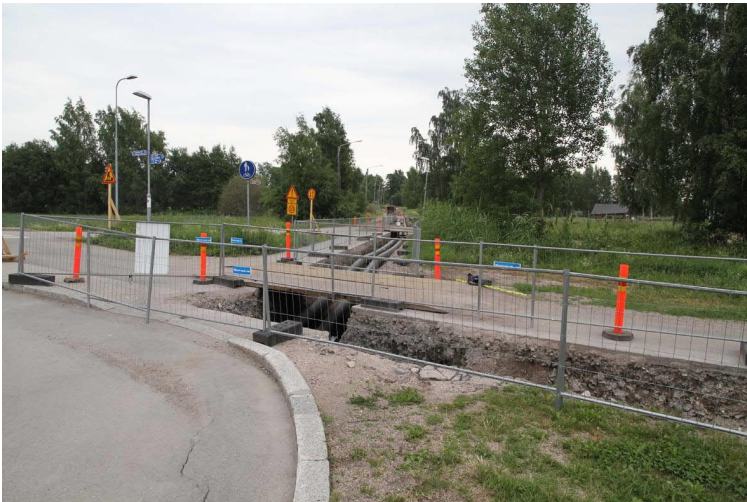
Kuva 30. Putkikaivantoa itään päin kuvattuna kohdasta, missä kaivanto kääntyy lounaaseen. Kuvaussuunta E. Kuva Heini Hämäläinen/HKM 25.6.2013.
