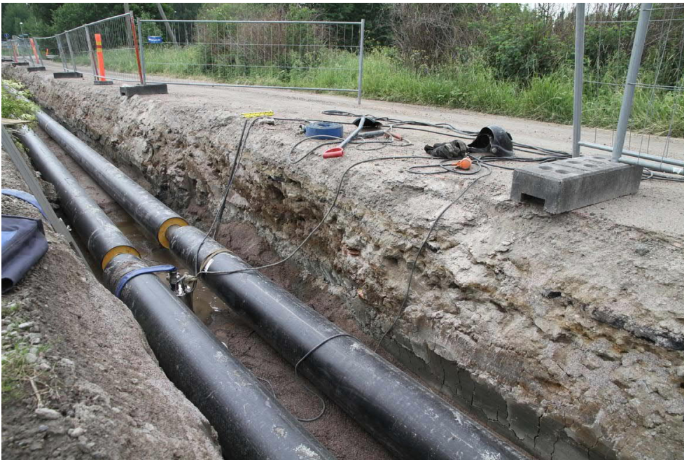
Kuva 24. Kaivannon pohjoislaitaa Tuomarinkyläntien varrelta. Profiilissa näkyvissä hiekkakerrosten lisäksi saven päällä oleva tiilimurska. Kuvaussuunta WNW. Kuva Heini Hämäläinen/HKM 25.6.2013.
