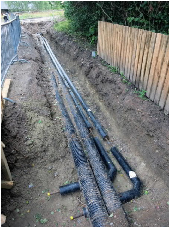
Kuva 37. Kaisanmäenkuja, rakennus 40. Edellinen tilanne toisesta suunnasta kuvattuna. Uudet putket kääntyvät kohti talon nurkkaa, kun vanhat tekevät vielä ison mutkan etelään kaivon kautta. Kuvaussuunta NNE. Kuva Markku Heikkinen/HKM 29.8.2014.
