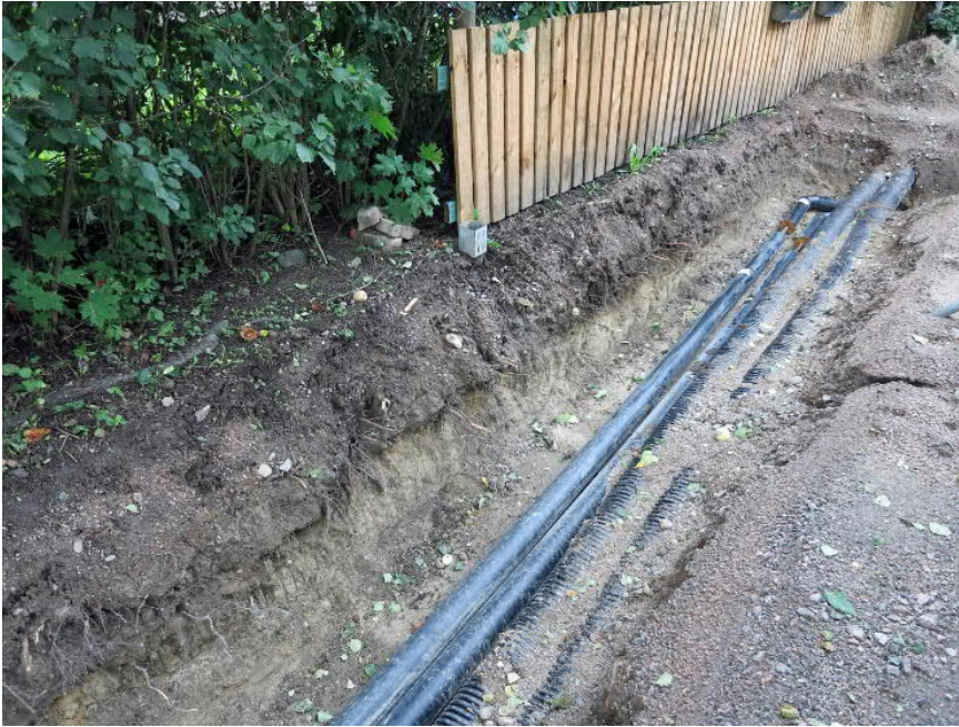
Kuva 36. Kaisanmäenkuja, rakennus 40. Edellisen kaivannon itäprofiilia, jossa koskematon silttikerros on lähellä maanpintaa. Kuvaussuunta N. Kuva Markku Heikkinen/HKM 29.8.2014.
