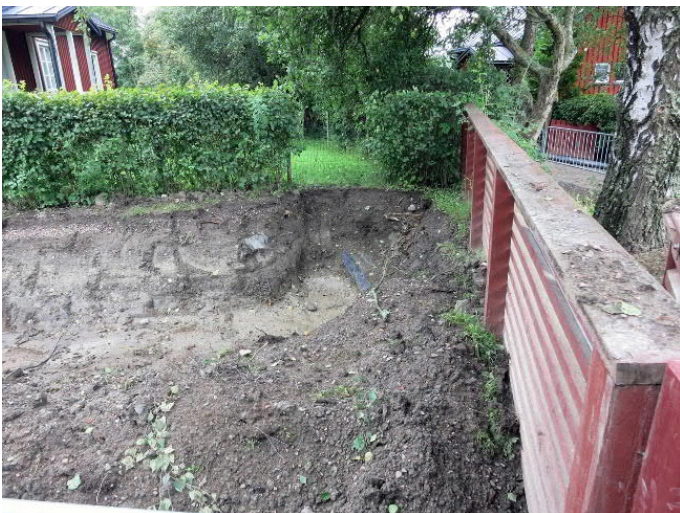
Kuva 40. Kaisanmäenkuja, rakennus 16. Vanhojen putkien linja meni rakennuksen länsipuolelle. Uusia putkia varten on kaivettu kaivantoa kuvan vasempaan reunaan kohti rakennuksen koillisnurkkaa. Kuvaussuunta SW. Kuva Markku Heikkinen/HKM 29.8.2014.
