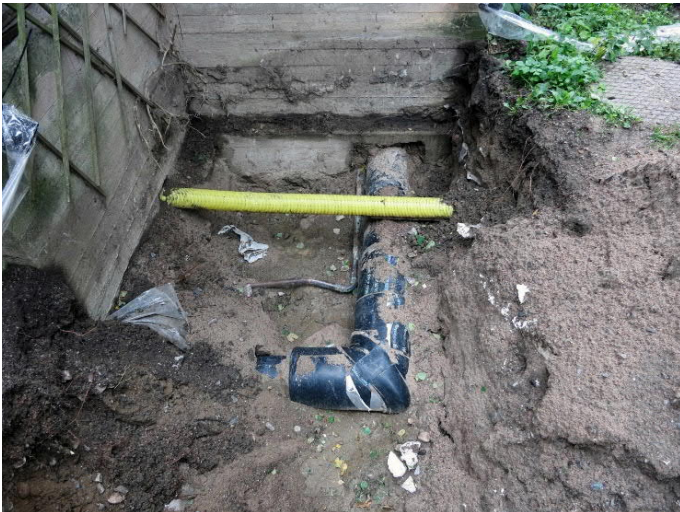
Kuva 39. Kaisanmäenkuja, rakennus 40. Vanha kaukolämpöputki tili rakennuksen koillisnurkkaan etelästä. Kuvaussuunta NW. Kuva Markku Heikkinen/HKM 29.8.2014.
