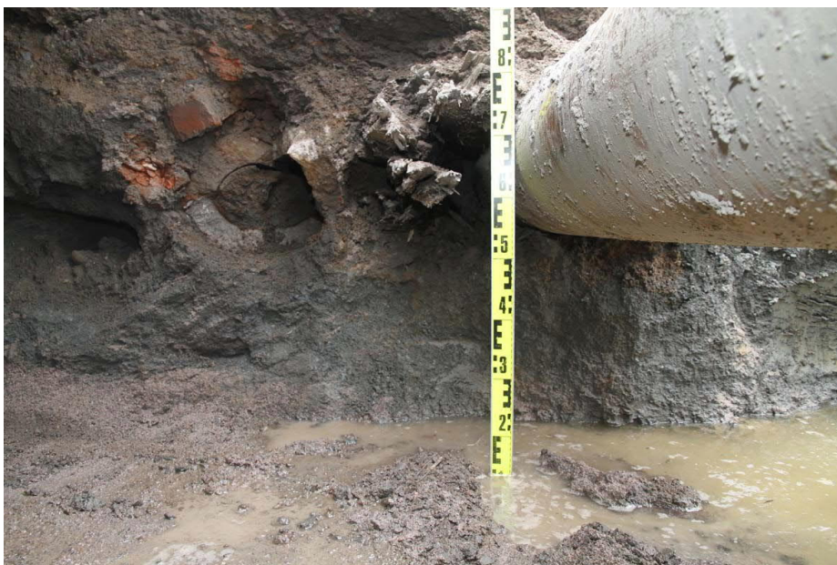
Kuva 10. Kuten yllä. Putkien alla on luonnollinen harmaa savi. Kuvaussuunta W. Kuva Heini Hämäläinen/HKM 25.6.2013.
