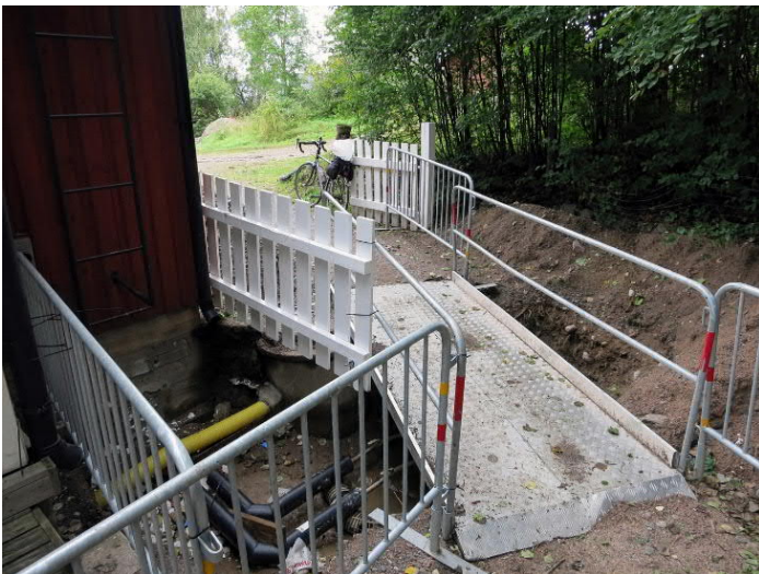
Kuva 43. Kaisanmäenkuja, rakennus 41. Uusien putkien kaivanto rakennuksen koillisnurkassa. Kuvaussuunta NNW. Kuva Markku Heikkinen/HKM 29.8.2014.
