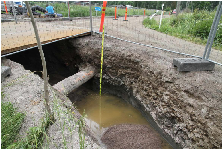
Kuvat 13-15. Kaivannon koillisosaa Strandmaninkujalla lounaaseen kuvattuna. Kaivannon koillispäässä luoteisprofiilissa oli saven päällä kivisiä tai soraisia hiekkakerroksia ja 'penkan puolella' kaakkoisprofiilissa savihiekkaa ja karkeaa hiekkaa. Kuvaussuunta SW. Kuvat Heini Hämäläinen/HKM 25.6.2013.
