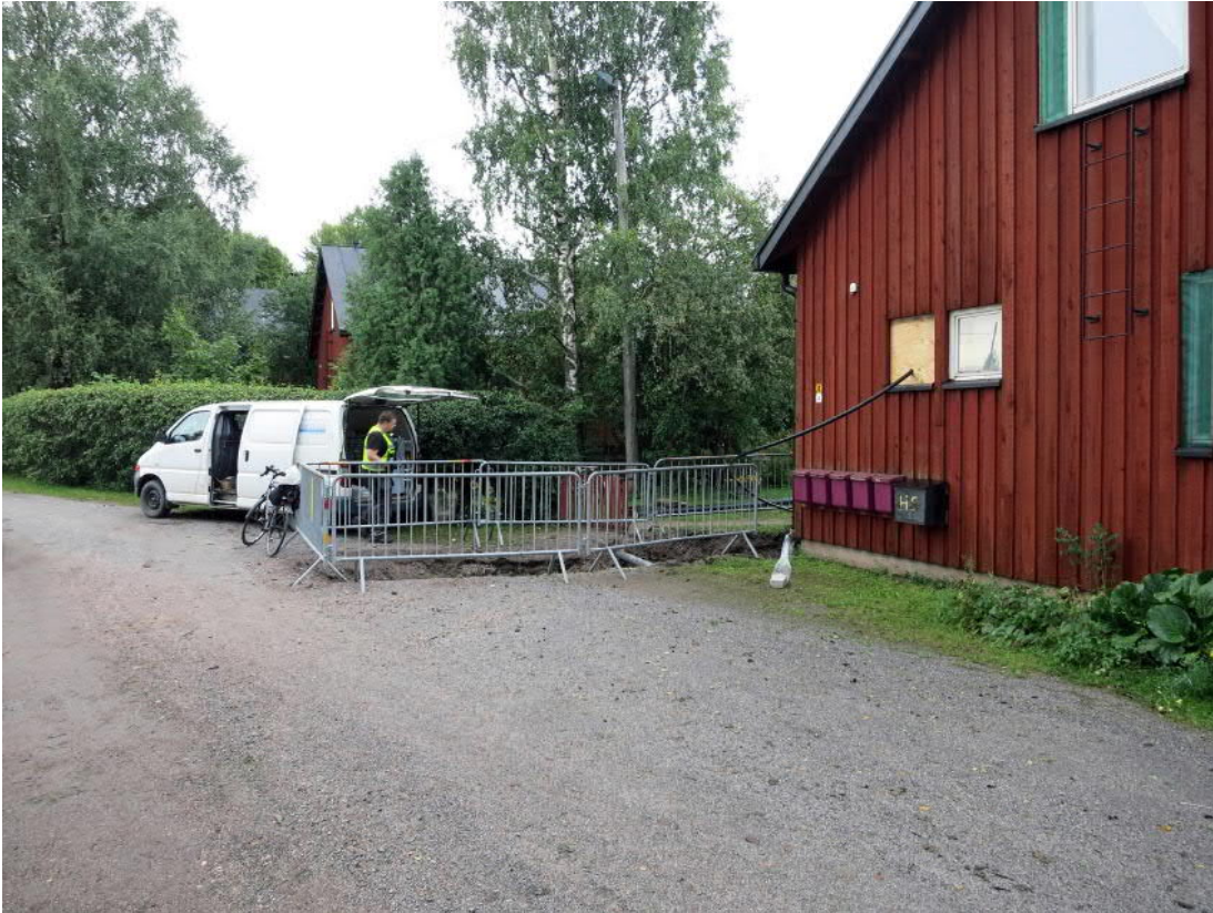
Kuva 32. Kaisanmäenkuja, rakennus 39. Uuden kaukolämpöputken kaivanto alkoi Kaisanmäenkujalta. Kuvaussuunta SE. Kuva Markku Heikkinen/HKM 29.8.2014.
