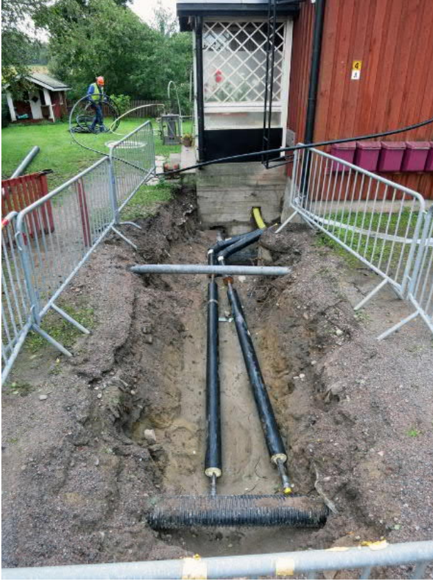
Kuva 34. Kaisanmäenkuja, rakennus 39. Uudet putket johtivat suoraan rakennuksen lähimpään nurkkaan sisäänmenoa varten. Vanhat putket, jotka sijaitsivat maan sisässä kuvassa kaivannon vasemmalla puolella, kiersivät taustalla näkyvän miehen kautta samaan sisäänmenoaukkoon. Kuvaussuunta SSW. Kuva Markku Heikkinen/HKM 29.8.2014.
