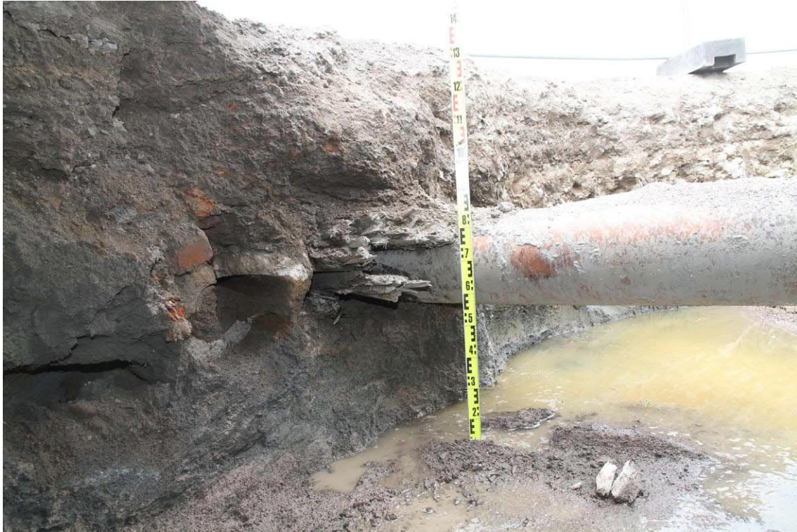
Kuva 11. Kuten yllä. Muoviputken ympärille on aseteltu hirsä/puita. Kuvaussuunta NW. Kuva Heini Hämäläinen/HKM 25.6.2013.
