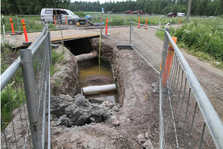
Kuvat 13-15. Kaivannon koillisosaa Strandmaninkujalla lounaaseen kuvattuna. Kaivannon koillispäässä luoteisprofiilissa oli saven päällä kivisiä tai soraisia hiekkakerroksia ja 'penkan puolella' kaakkoisprofiilissa savihiekkaa ja karkeaa hiekkaa. Kuvaussuunta SW. Kuvat Heini Hämäläinen/HKM 25.6.2013.
