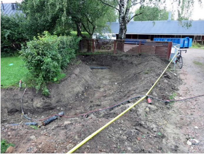
Kuva 41. Kaisanmäenkuja, rakennus 16. Uusien putkien kaivanto. Vanhat näkyvät taustalla. Kuvaussuunta NW. Kuva Markku Heikkinen/HKM 29.8.2014.
