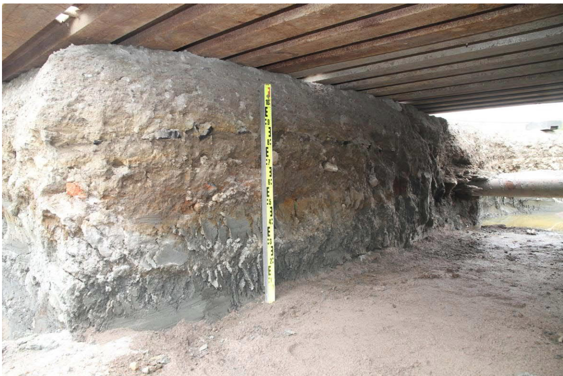
Kuva 6. Kuten yllä. kaivannon länsiprofiilia luoteeseen päin kuvattuna. Noin 50 cm tien pinnasta alas näkyy paloja asfalttilevyä. Kuvaussuunta NW. Kuva Heini Hämäläinen/HKM 25.6.2013.
