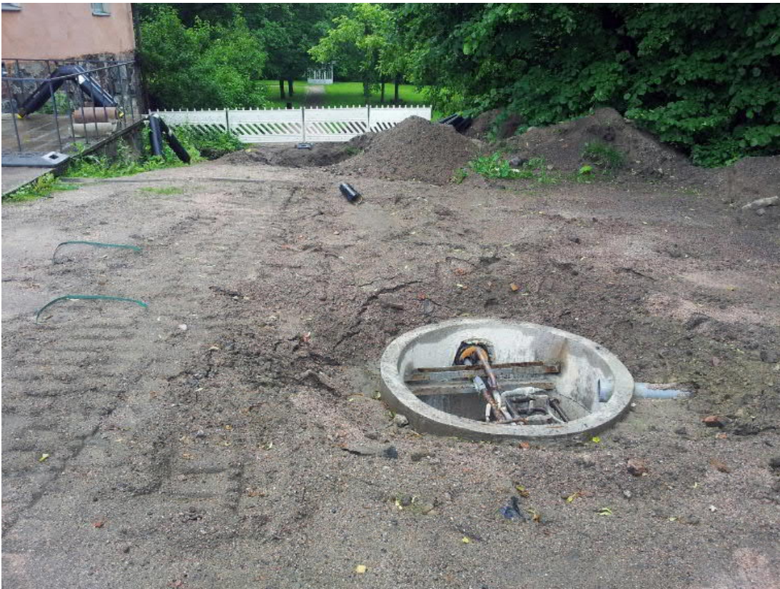
Kuva 51. Kartanon päärakennus. Etualalla näkyy kaukolämpöverkon kaivo ja taustalla uudistetun putkiston kohta. Kuvaussuunta SSE. Kuva Markku Heikkinen/HKM 24.6.2014.
