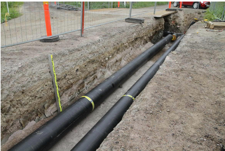
Kuva 17. Latta on kaivannossa HP2:n kohdalla. Kuvaussuunta E. Kuva Heini Hämäläinen/HKM 25.6.2013.
