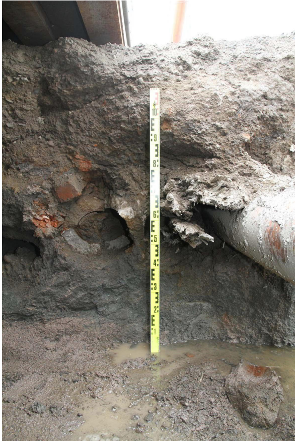
Kuva 9. Tien poikki menevän kaivannon länsiprofilia. Vasemmalla betoninen litskaantunut putki tiilisine täyttömaineen ja sen vieressä käytössä oleva oranssi putki, molemmat sijaitsevat noin 70 cm maanpinnasta alaspäin Tuomarinkyläntien pohjoislaidalla. Kuvaussuunta W. Kuva Heini Hämäläinen/HKM 25.6.2013.
