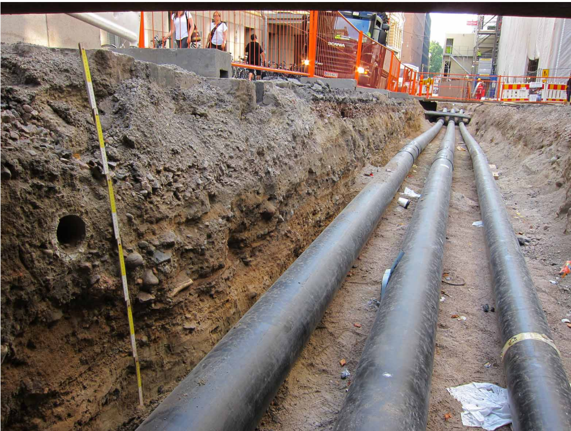
Kuva 16. Kaivannon itäprofiilia etelään päin kuvattuna. Alaosassa moreeni ja yläosassa uudet sorat. Väliin jää kirjavia kivisiä ja hiekkaisia kerroksia, joita on löytöjen puuttuessa vaikea ajoittaa, mutta vaikuttavat uusilta. Kuva Heini Hämäläinen/HKM 30.7.2014.
