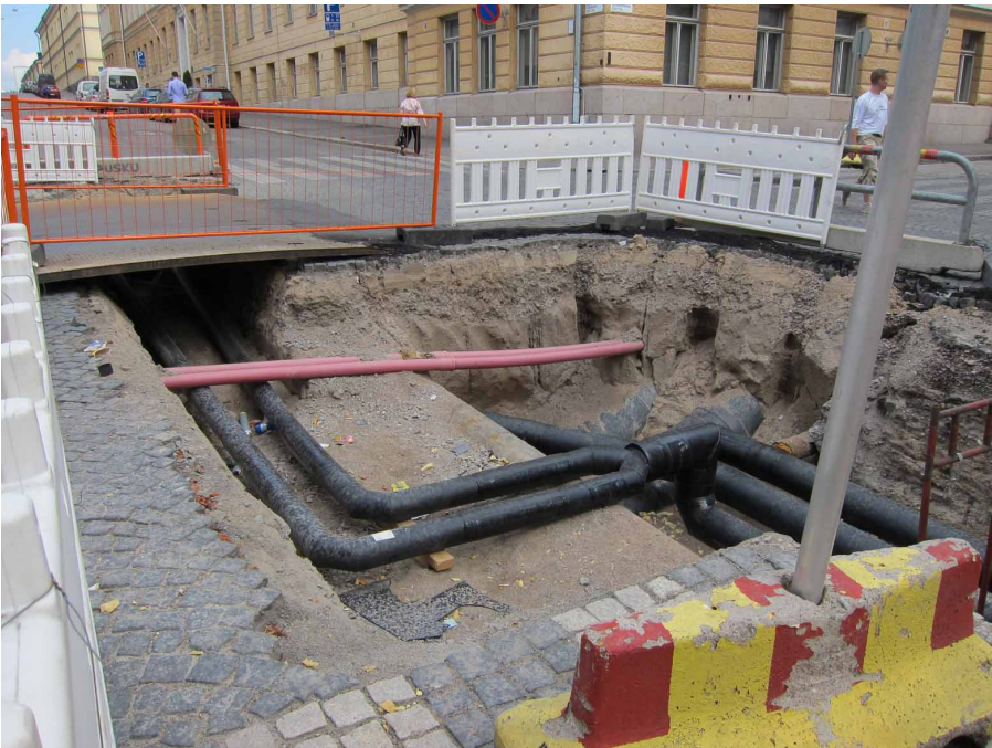
Kuva 6. Kuten yllä, koilliseen päin kuvattuna. Profiileissa uusia täyttömaita. Kuva Heini Hämäläinen/HKM 30.7.2014.
