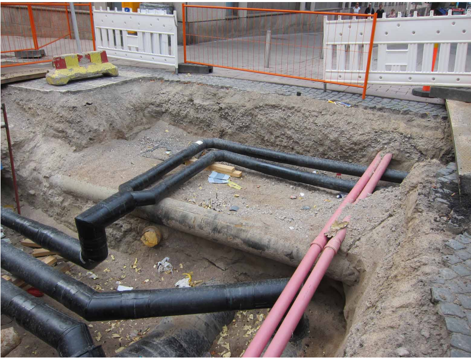
Kuva 9. Risteyskohdan kaivantoa lounaaseen päin kuvattuna. Kuva Heini Hämäläinen/HKM 30.7.2014.
