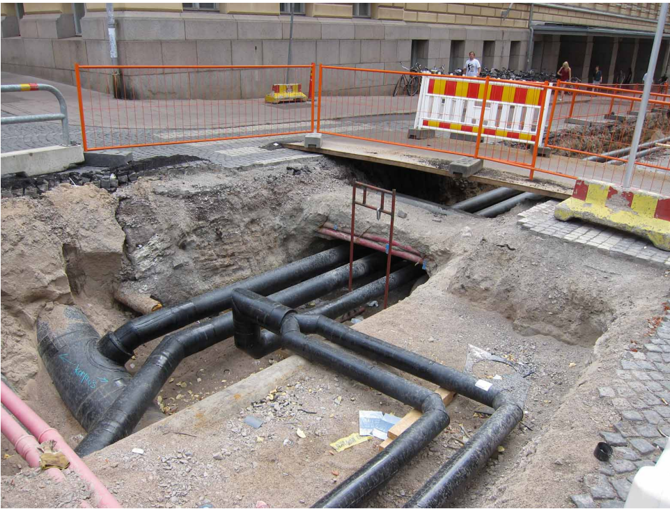
Kuva 7. Kuten edellä, kaakkoon päin kuvattuna. Taustalla Helsingin yliopiston päärakennuksen uusi puoli. Uuden mustat putket alittavat kuvassa sähkö- ja tietoliikennekaapelimatot suojatien kohdalla. Kuva Heini Hämäläinen/HKM 30.7.2014.
