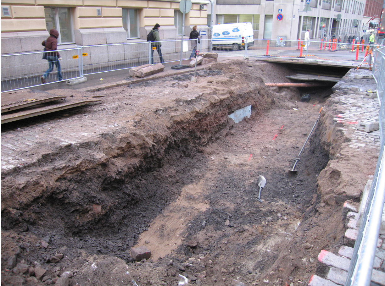
Kuva kaukojäähdytysputkien asennuksen valvonnasta Yliopistokatu-Unioninkatu 2005-2006, Kuvaussuunta länteen kohti Fabianinkadun risteystä. Heikkinen/HKM 30.11.2005.
