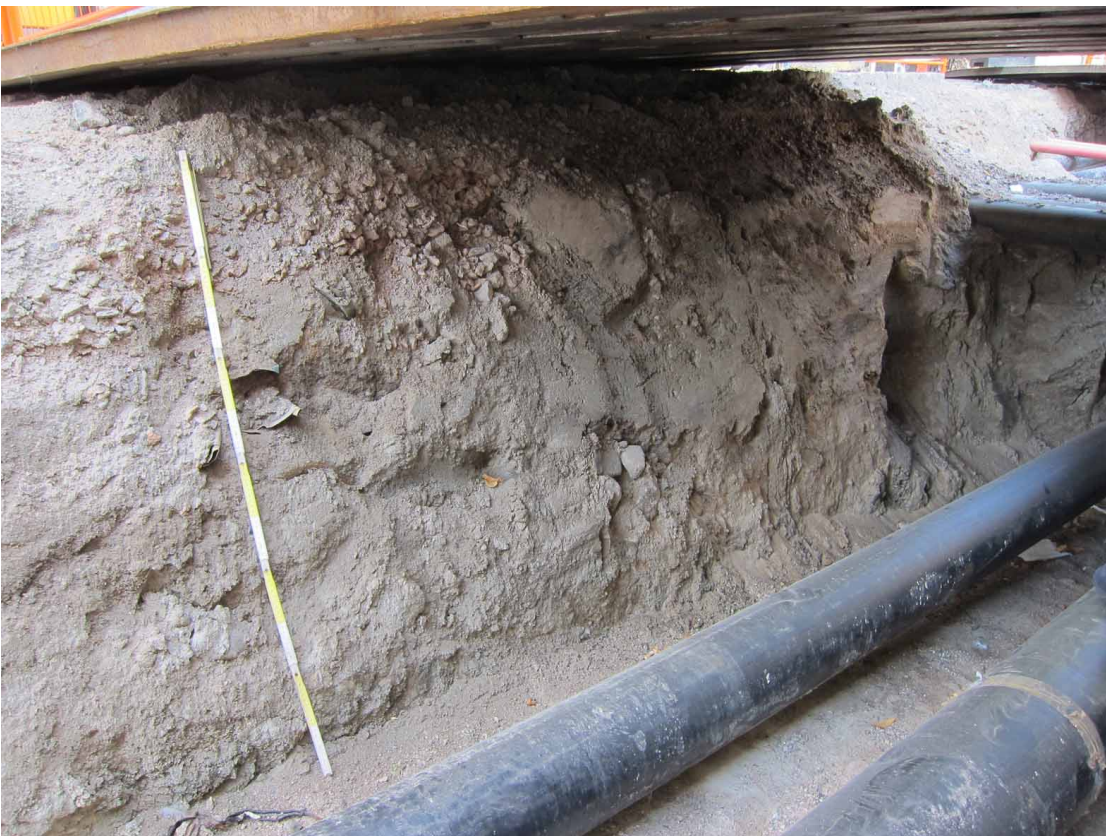
Kuva 27. Länsiprofilia risteyksen ajosillan alta. Täyttömaassa näkyy muovin ja pahvinrepaleita tuumastukin kohdalla ja taustalla on jo risteysalueen maanokset sekoittanutta putkiviidakkoa. Kuva Heini Hämäläinen/HKM 30.7.2014.
