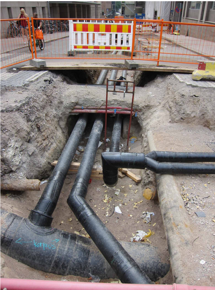
Kuva 8. Kaivantoa ja putkia etelään päin kuvattuna. Kuva Heini Hämäläinen/HKM 30.7.2014.
