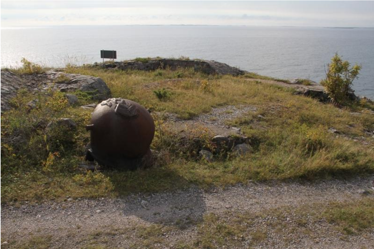
Tykkiasema NE. Etualalla suojakupu.
