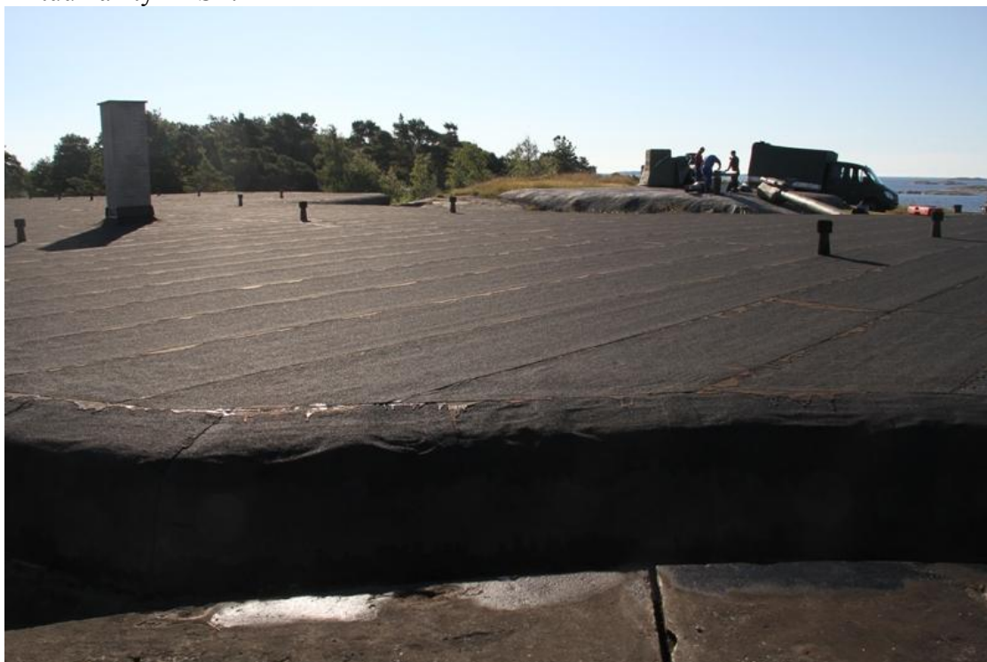
Tykin suojuhuoneen katto.
