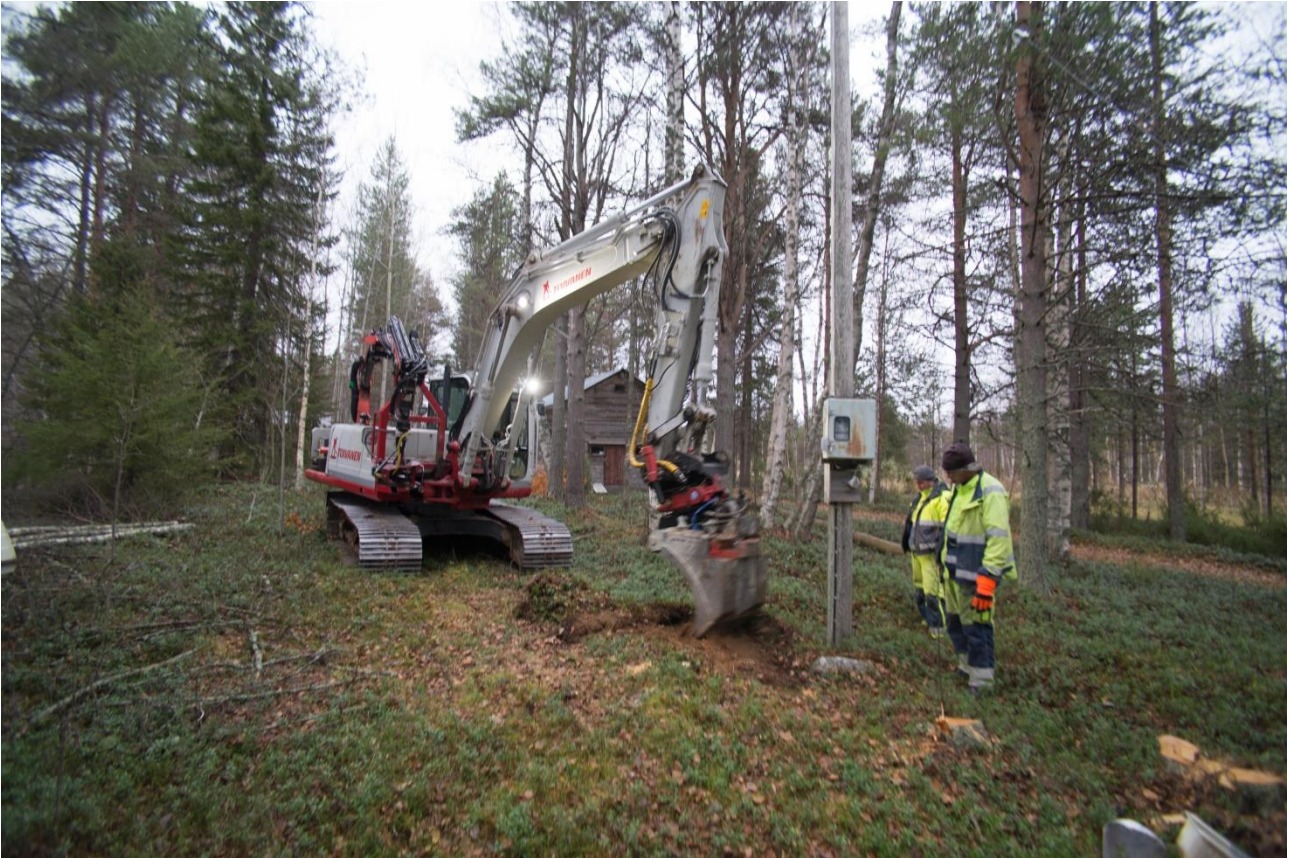
SKDG 201608:4 Kaivannon 1 pintaturvetta kuoritaan kaivinkoneella.
