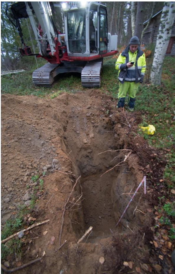
SKDG 201608:5 Kaivanto 1 kuvattuna etelästä.
